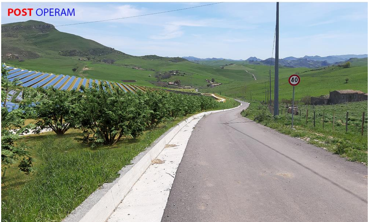
Figura 31 – Ante e Post Operam: vista dalla strada che costeggia a sud l'impianto. Il campo agro-fotovoltaico si svilupperà a sinistra.
