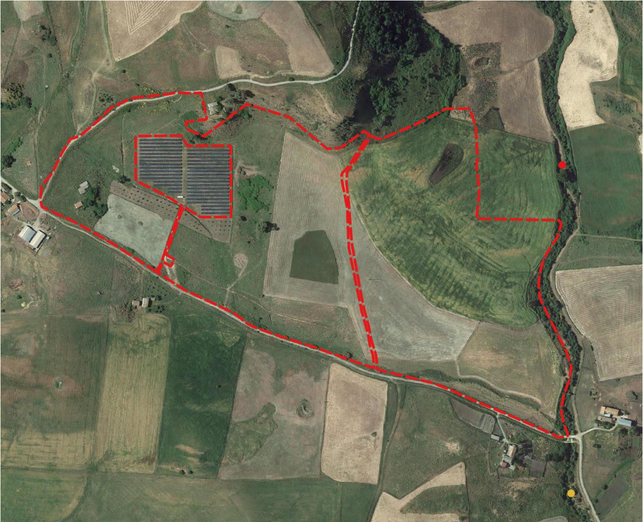
Figura 11 – Stazioni di monitoraggio puntuali, secondo il criterio idrologico Monte (cerchio rosso) – Valle (cerchio giallo)
