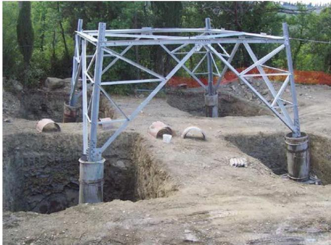
Per la realizzazione di un elettrodotto aereo l'unica fase che comporta movimenti di terra è data dall'esecuzione delle fondazioni dei sostegni. La fondazione dei sostegni a traliccio della linea aerea oggetto di intervento è formata da quattro plinti isolati, uno per ciascun montante, posti ad una distanza pari all'interasse dei montanti del traliccio stesso (cfr. immagine sopra).
