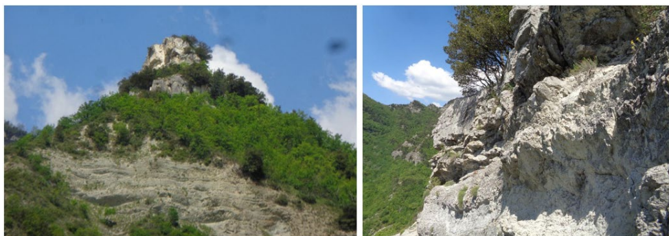
Figura 7-11: Vista sul Monte Pizzo e dettaglio della cornice sommitale nei pressi di una recente nicchia di crollo.
