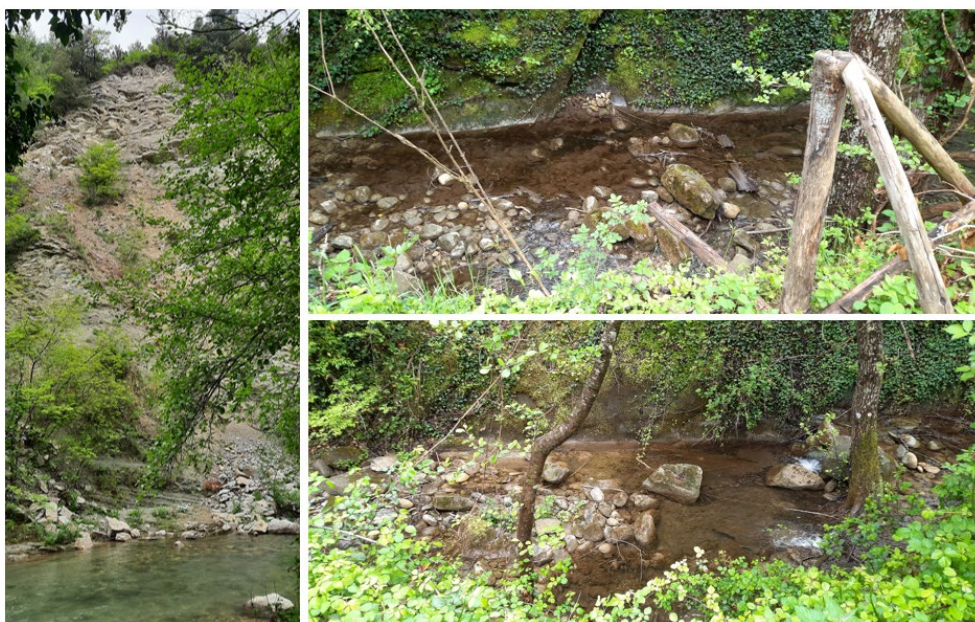
Figura 7-10: Parete esposta che può essere possibile fonte di crollo, e testimoni muti individuati durante i sopralluoghi.
