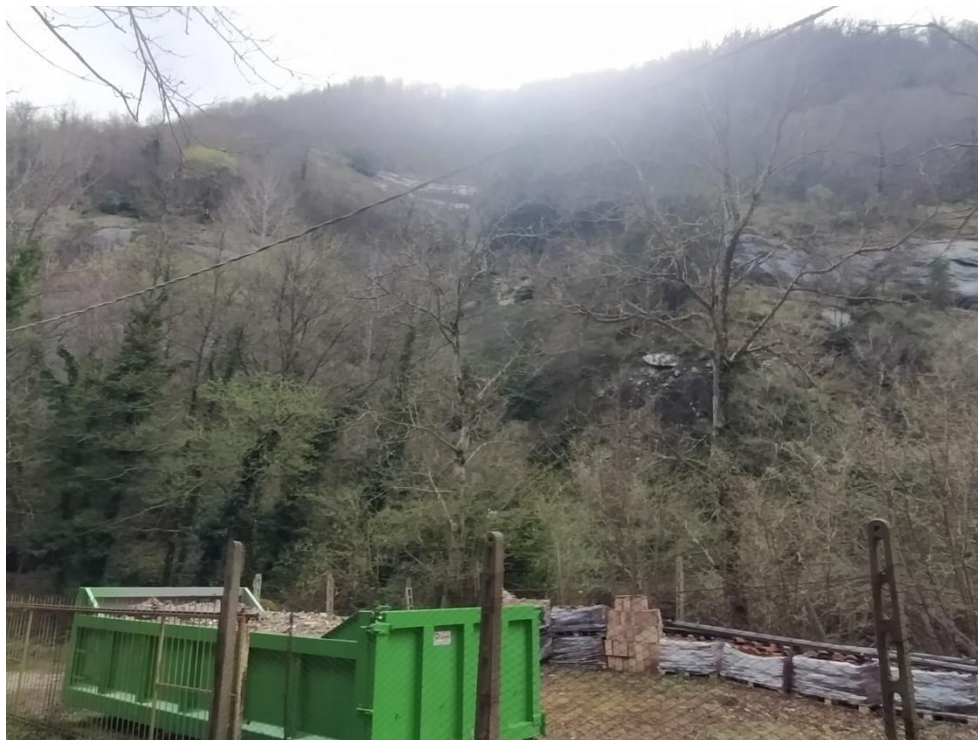
Foto 5-1 – Panoramica versante in cui ha sede la spalla sinistra del Viadotto Quintodecimo; si noti l'affioramento delle massive testate di strato del Flysch della Laga da cui si distaccano blocchi ciclopici.
