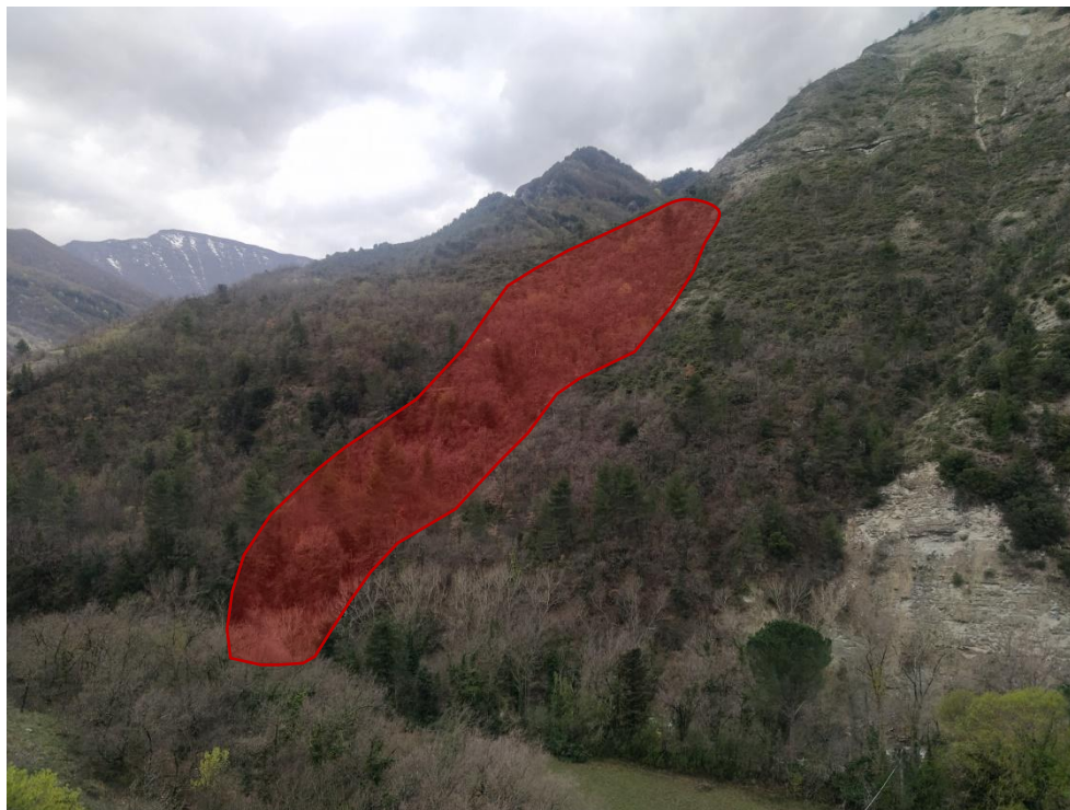
Foto 5-5 – Panoramica frana complessa osservata tra le pk. 4+350 e 4+550.
