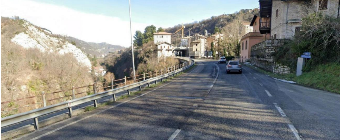
Figura 2.77: Vista dalla S.S.4 Salaria in corrispondenza dell'abitato Acquasanta Terme
