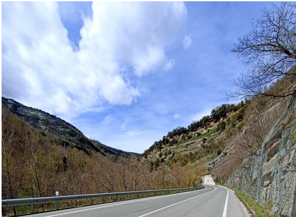
Figura 2-81 - Strada Statale 4 Salaria, inserita tra il fiume Tronto (che nella foto in oggetto scorre sulla sinistra) e le pareti rocciose costituite da banchi di arenarie (a destra). La SS4 segue l'andamento tortuoso della valle del fiume Tronto.
