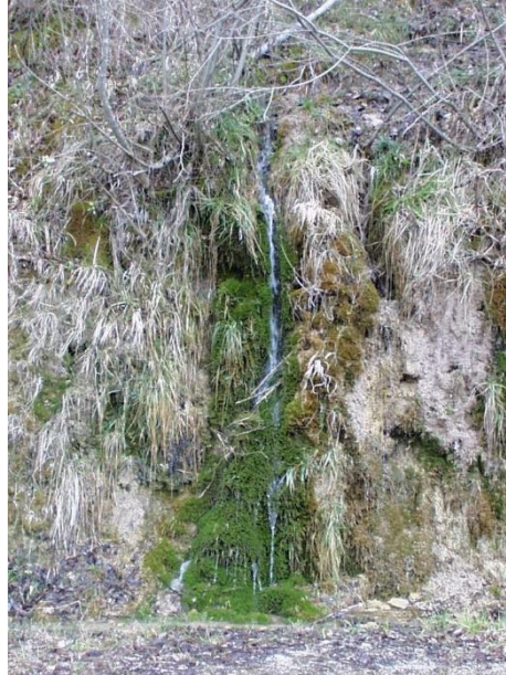
Figura 2.39: Emergenze idriche in prossimità della S.P.70 per Pozza, al contatto fra i travertini e le Marne con Cerroigna
