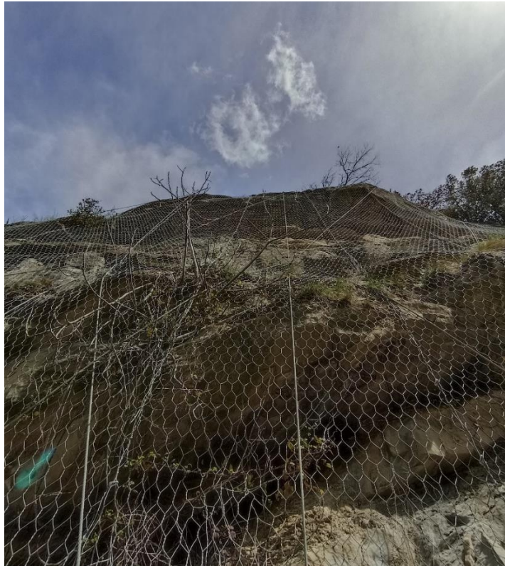
Figura 2-82 - Parete rocciosa composta da banchi di arenarie, con sistema di reti paramassi, situata in prossimità della Salaria, nel tratto che da Quintodecimo arriva sino a Favallanciatà
