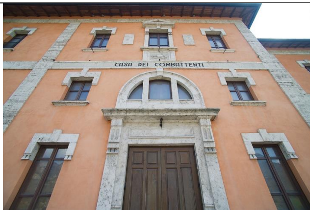
Ex teatro comunale – Casa dei Combattenti
