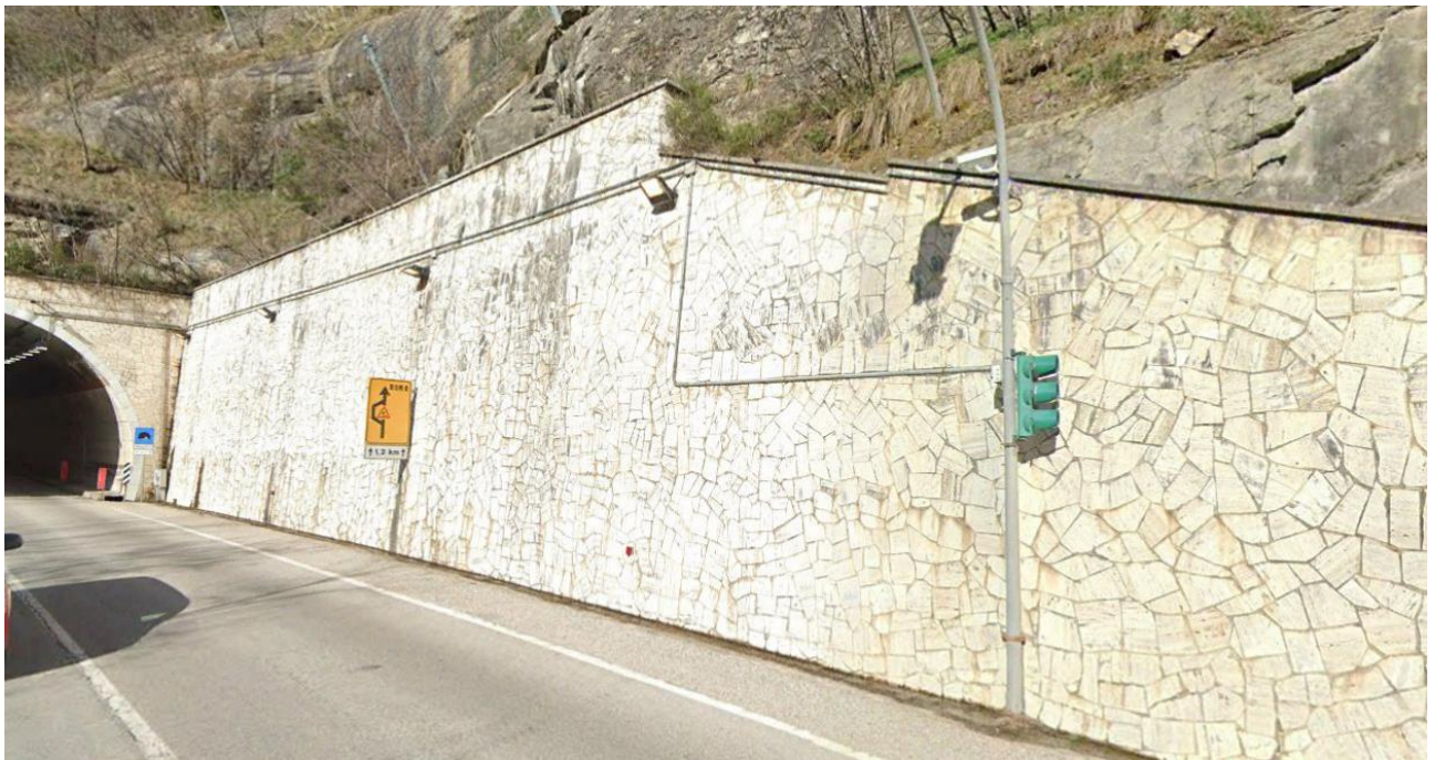
Figura 3.46 Rivestimento muro di contenimento - uscita galleria Valgarizia
