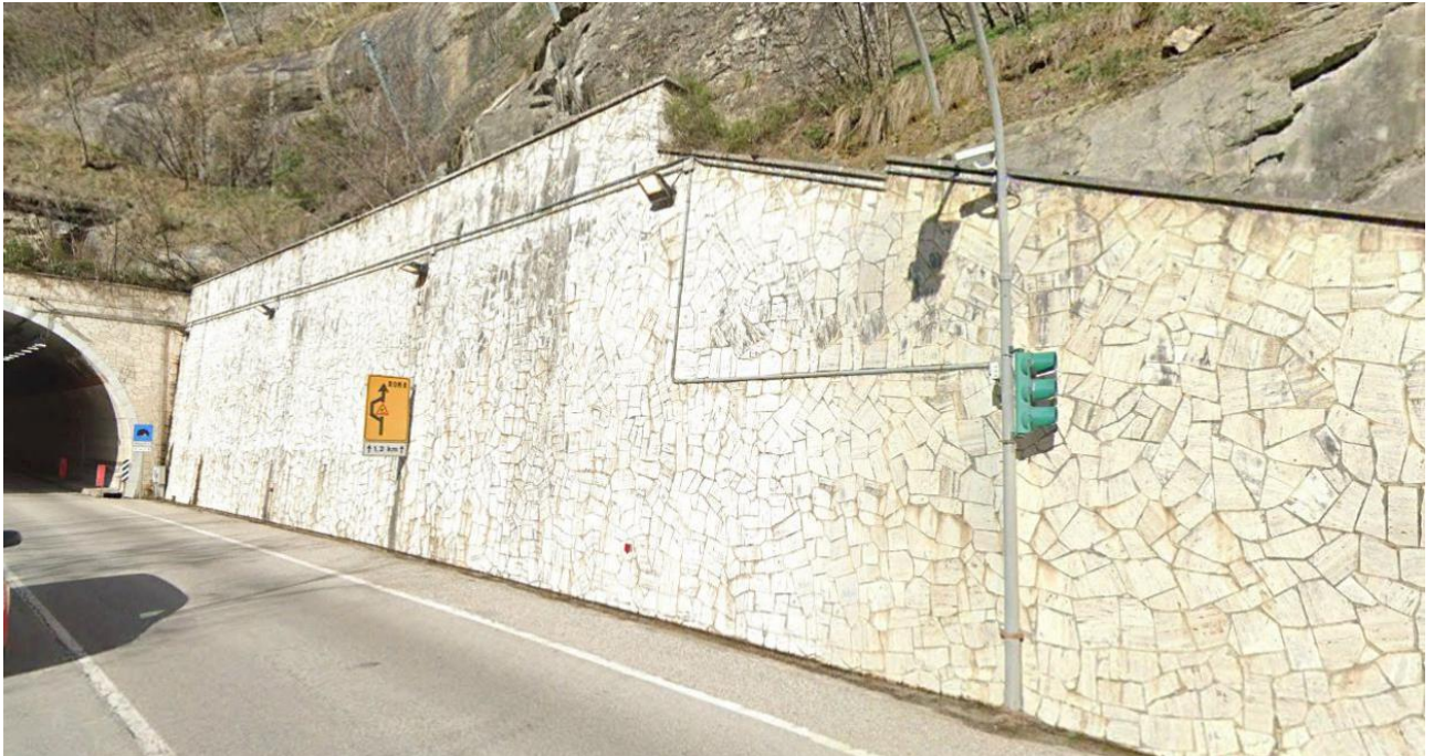
Figura 2.42: Rivestimento muro di contenimento - uscita galleria Valgarizia
