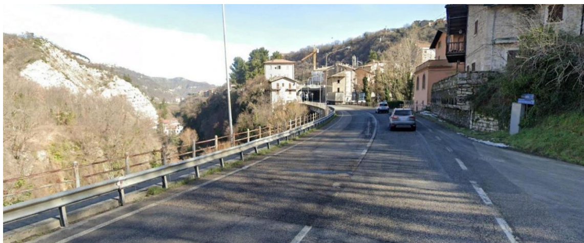
Figura 2.21: Vista dalla S.S.4 Salaria in corrispondenza dell'abitato Acquasanta Terme
