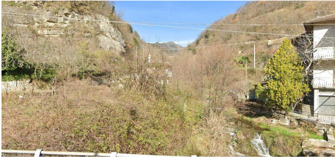
Figura 2.20: Vista dalla S.S.4 Salaria in corrispondenza del borgo di Quintodecimo
