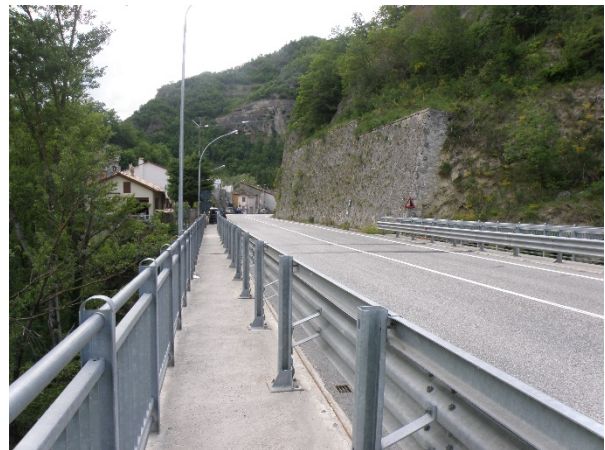
Figura 3.4: SS4 Viadotto Quintodecimo al km 158+000
