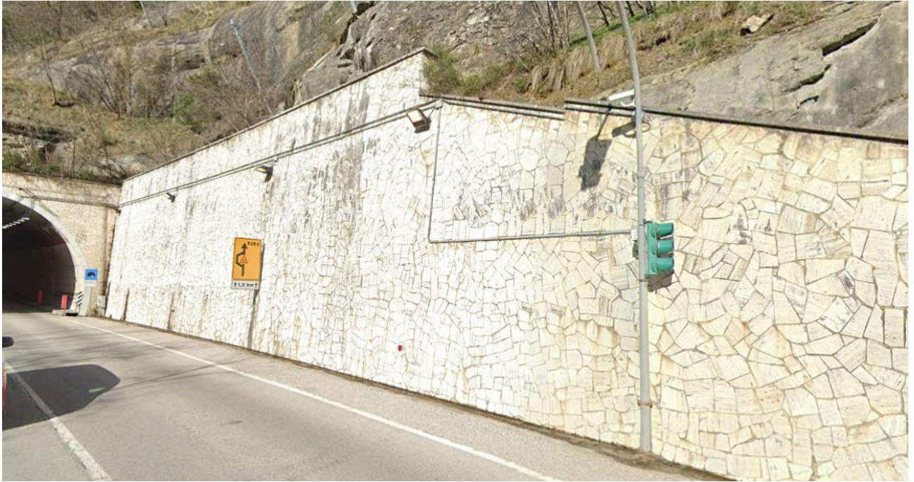
Figura 4-21: Rivestimento muro di contenimento - uscita galleria Valgarizia
