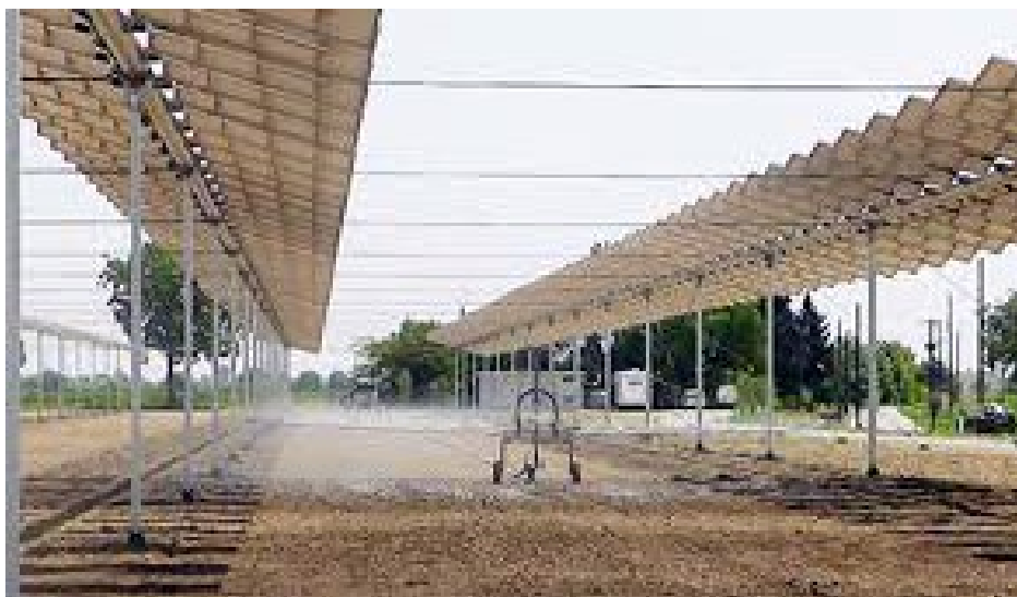
Impianto con predisposizione del terreno per la piantumazione dell'impianto di uliveto.
