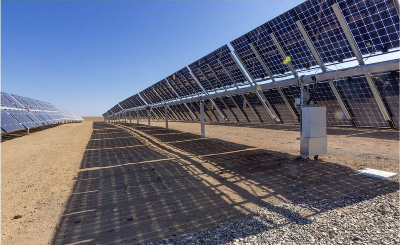
Figura 16 – Particolare strutture di sostegno impianto del tipo ad inseguimento monoassiale
