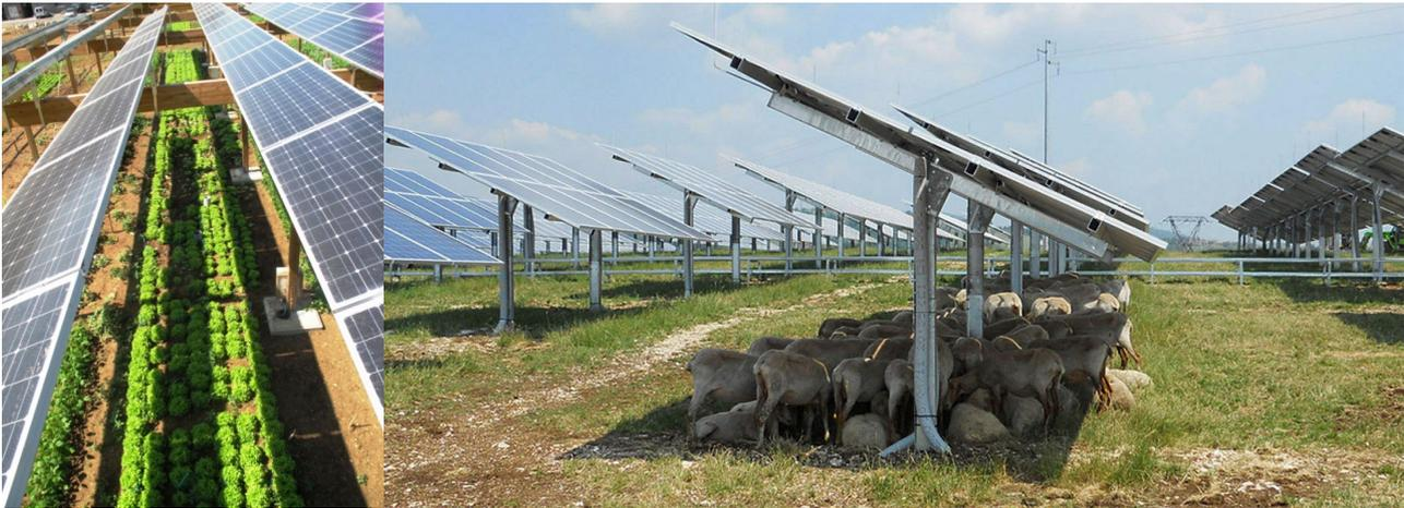
Figura 29 – Tipologie di impianto agro-fotovoltaico
