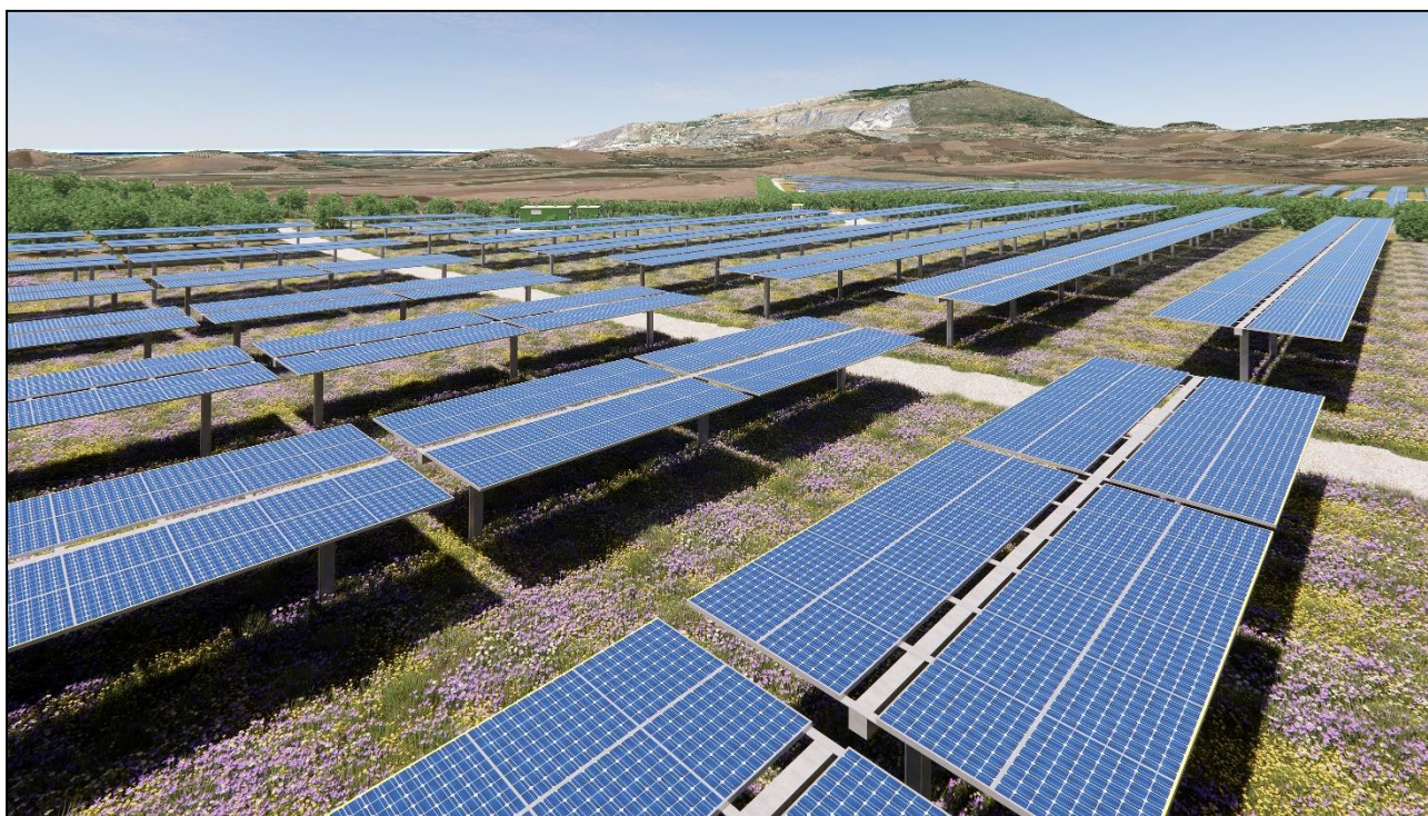
Figura 1 – Vista interna impianto
