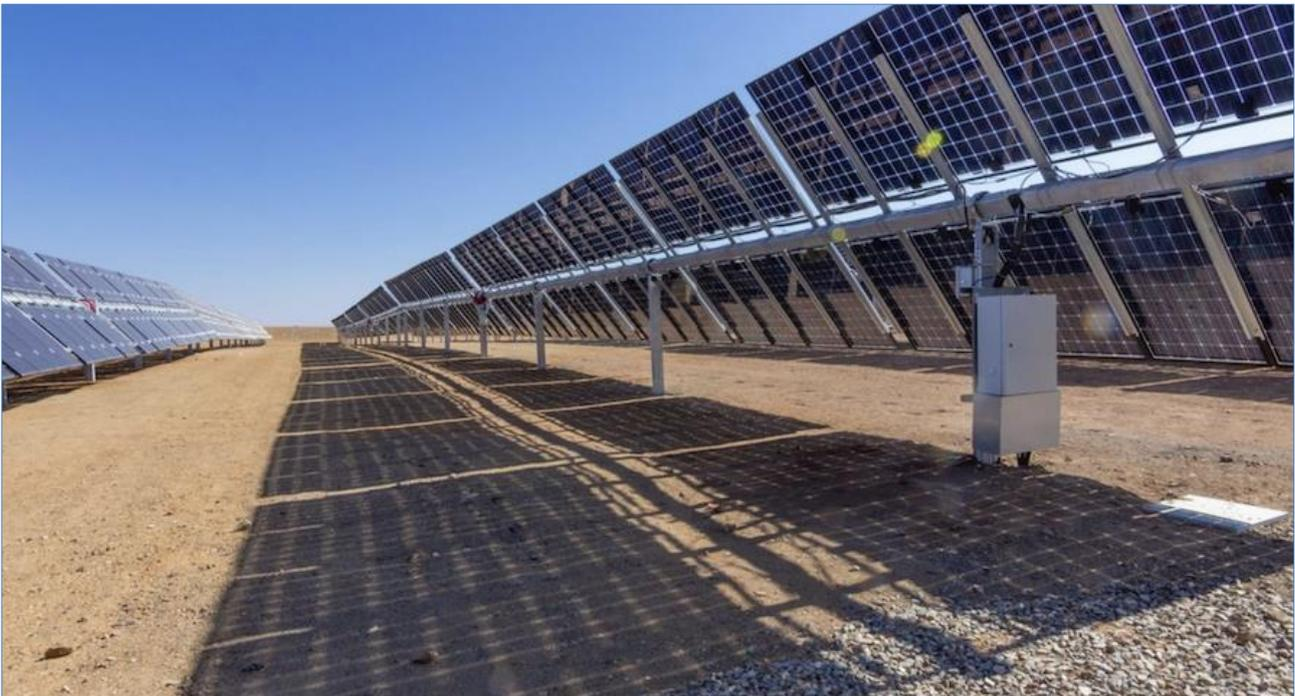
Figura 51 – Particolare strutture di sostegno impianto del tipo ad inseguimento monoassiale
