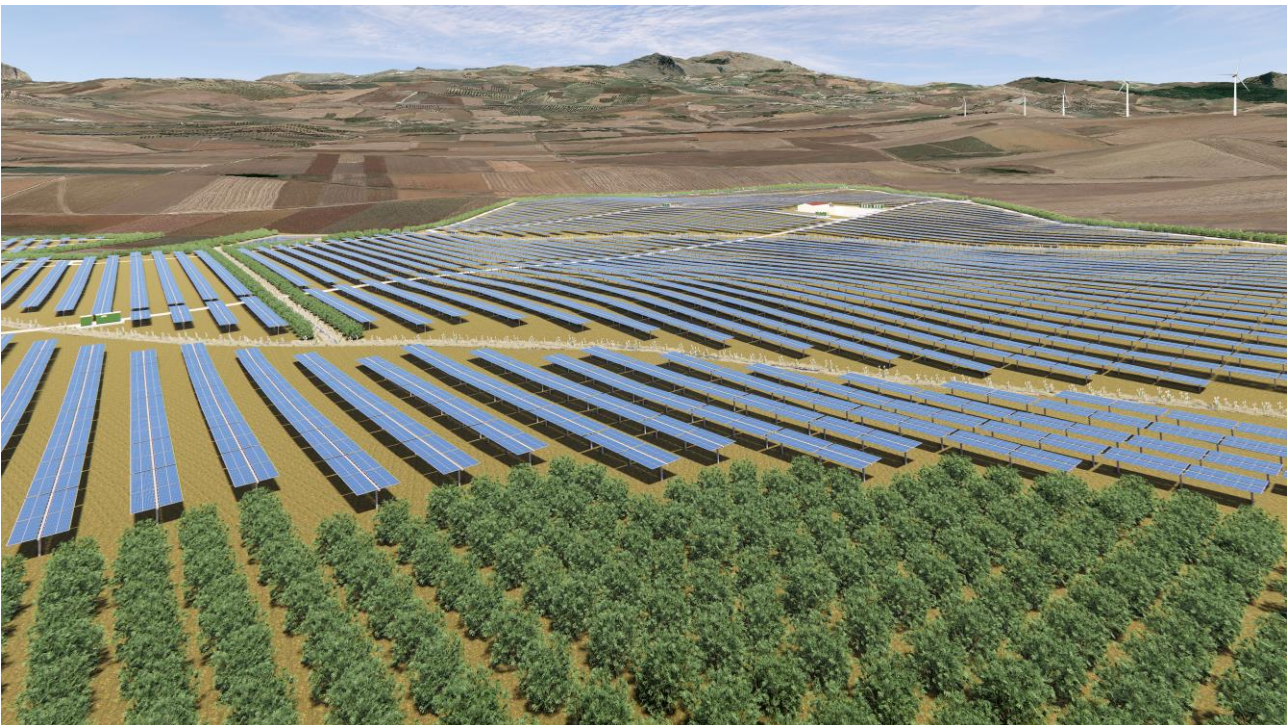
Figura 14 – vista dell'impianto agro-fotovoltaico "effetto lago"
