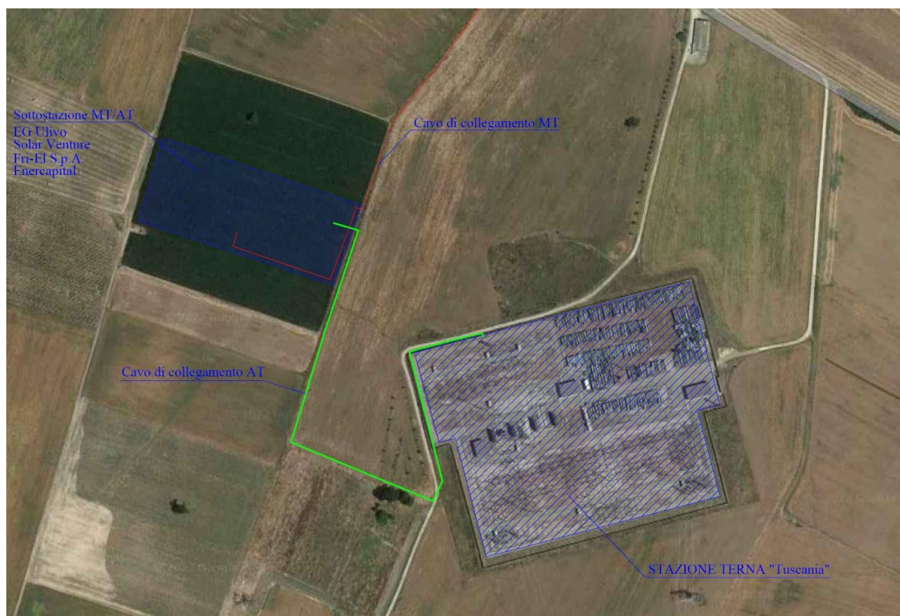
Figura 39 - Sottostazione di utenza su ortofoto
