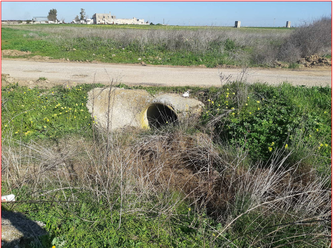
Fig. 11: Attraversamento idraulico n. 2.
