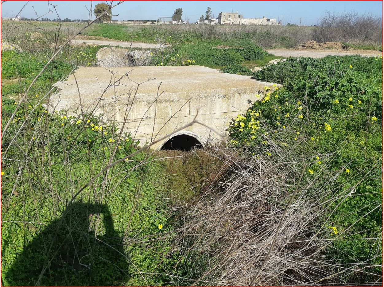
Fig. 10: Attraversamento idraulico n. 1.
