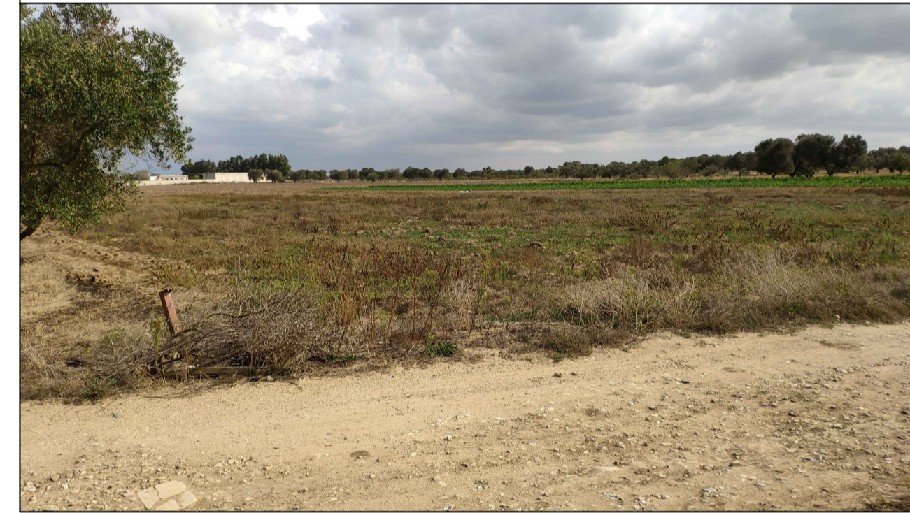
F5 - AREA IMPIANTO AGROVOLTAICO
