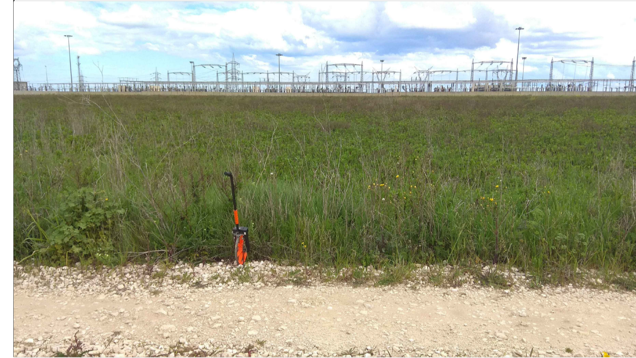
F3 - AREA STAZIONE ELEVAZIONE
