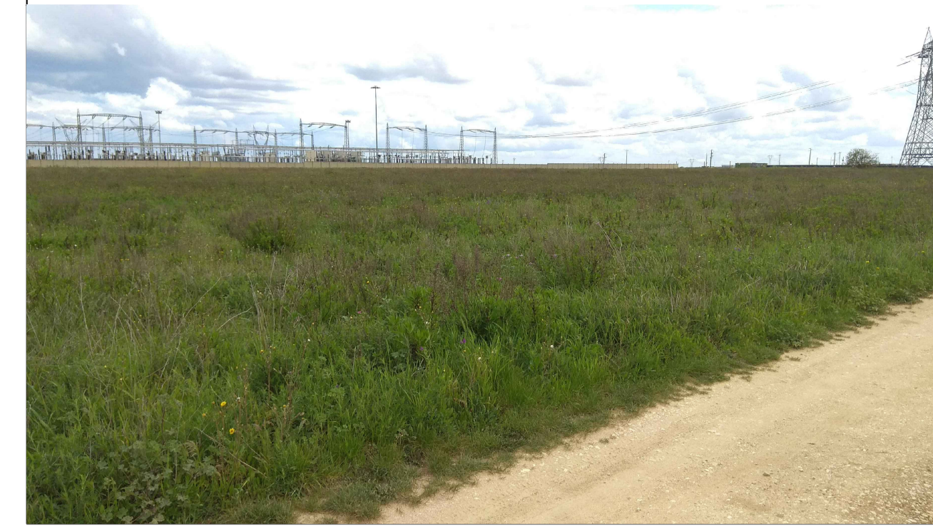
F2 - AREA STAZIONE ELEVAZIONE
