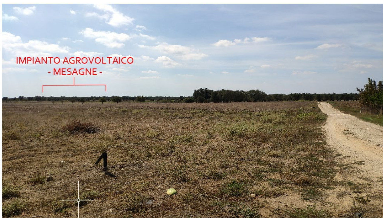
Figura 7: Vista prospettica dell'impianto da Masseria Specchia
