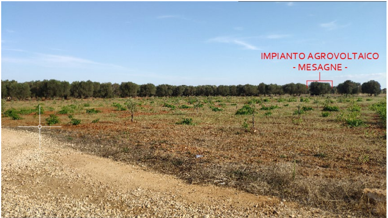
Figura 26: Vista dell'impianto dalla RER – Primo Punto
