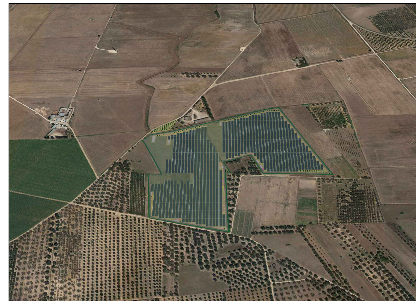
VISTA LATO OVEST POST OPERAM
