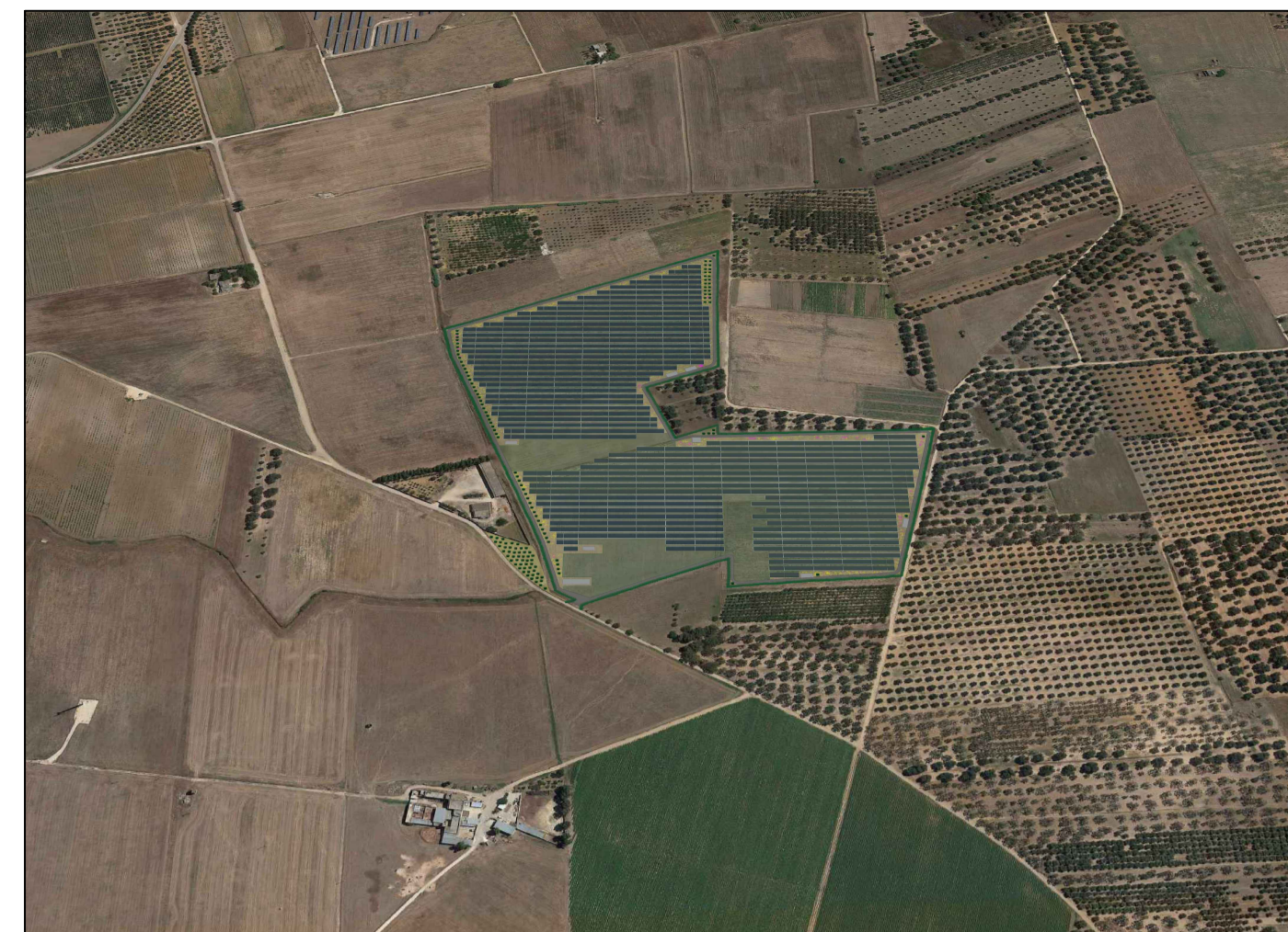
VISTA LATO NORD POST OPERAM
