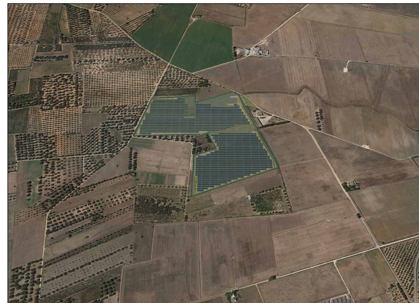
VISTA LATO SUD POST OPERAM
