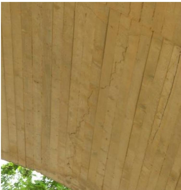
Figura 4.5 – Sottovia al km 333+670: Lesione associabile a un degrado superficiale lungo la volta
