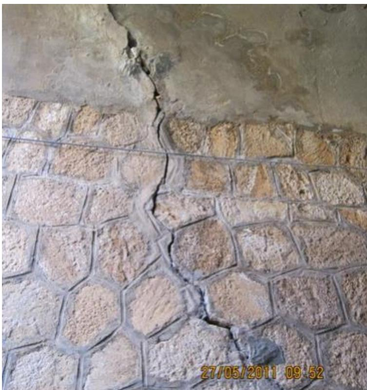
Figura 4.4 – Sottovia al km 317+264: Lesione passante sulle spalle, proveniente dalla volta in cls
