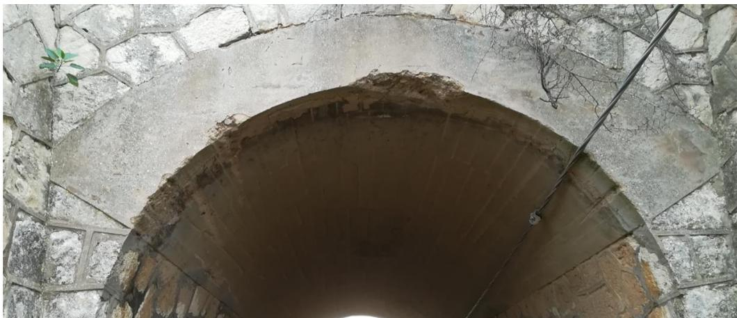
Figura 4.6 – Sottovia al km 349+697: Degrado medio diffuso sulla volta dell'arco in cls
