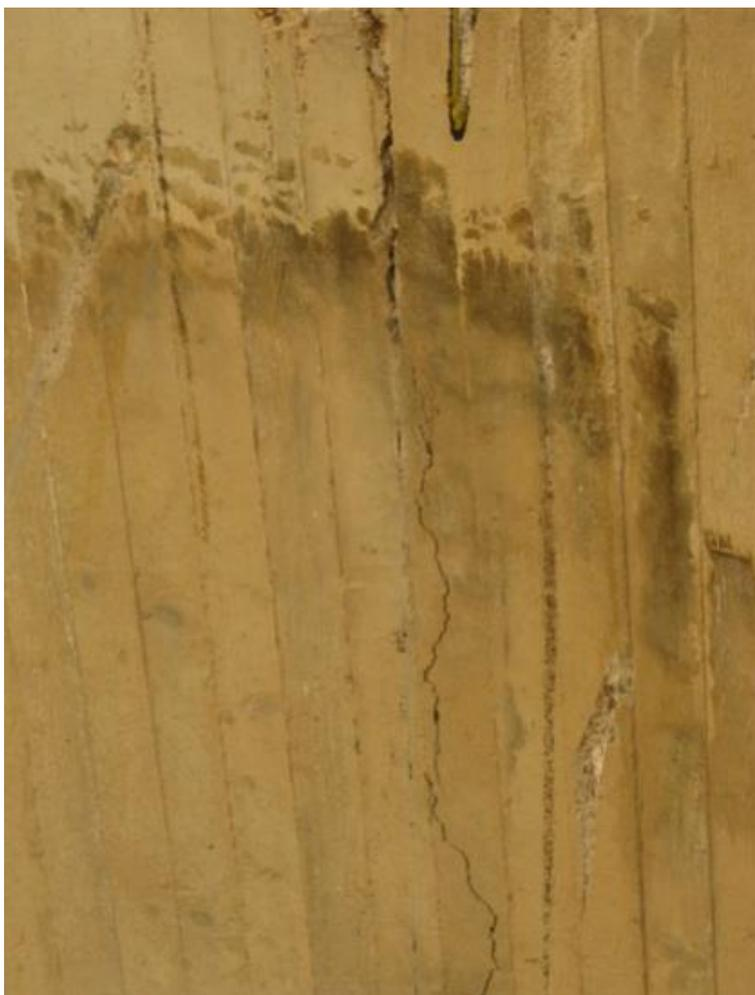
Figura 4.7 - Sottovia al km 333+670: Lesione associabile a un degrado profondo lungo la chiave della volta
