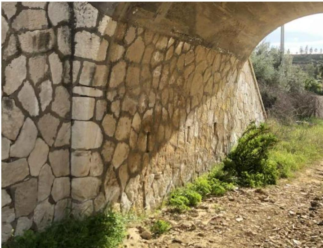
Figura 4.1 – Sottovia al km 351+805: Ammaloramento dovuto a infiltrazioni d'acqua sulla spalla
