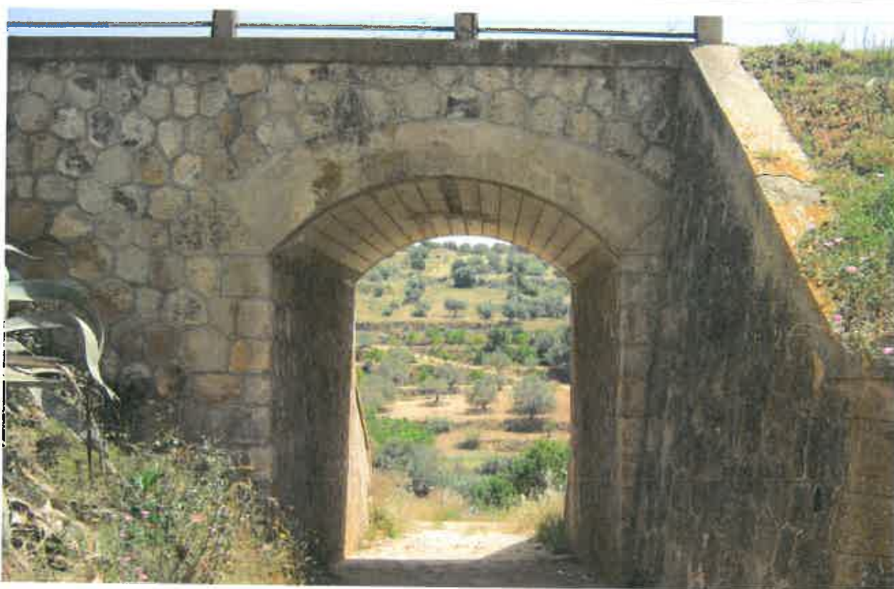
Foto 2 - Tipologia di muratura
