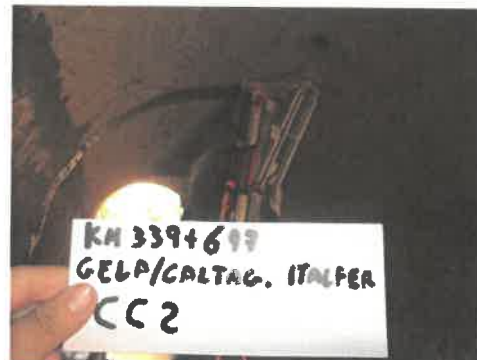
Fig. A.2-a - Fase di prelievo della carota CC2
