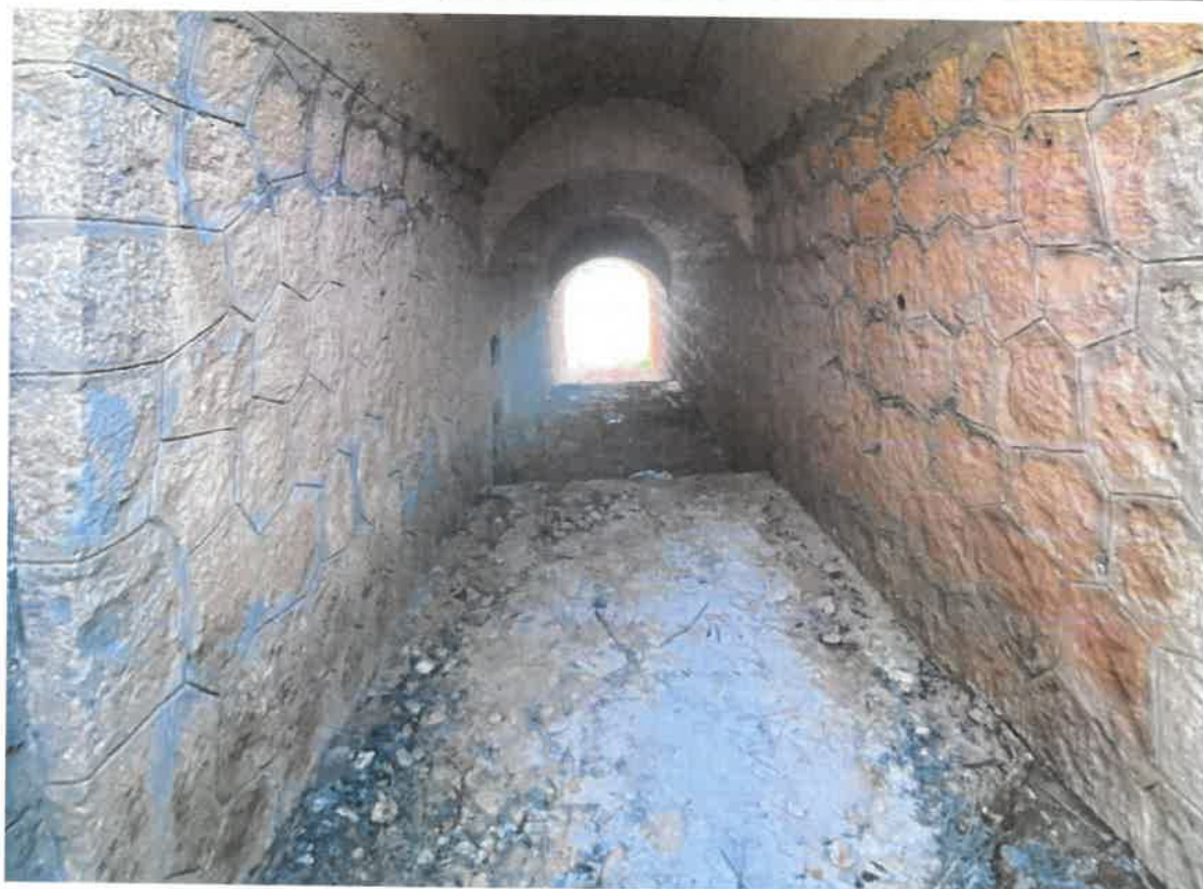
Foto 2 - Tipologia di muratura
