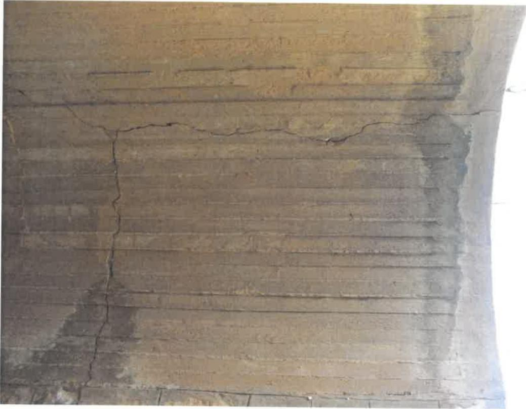
Foto 14 - Spalla ponte - Presenza di lesioni verticali
