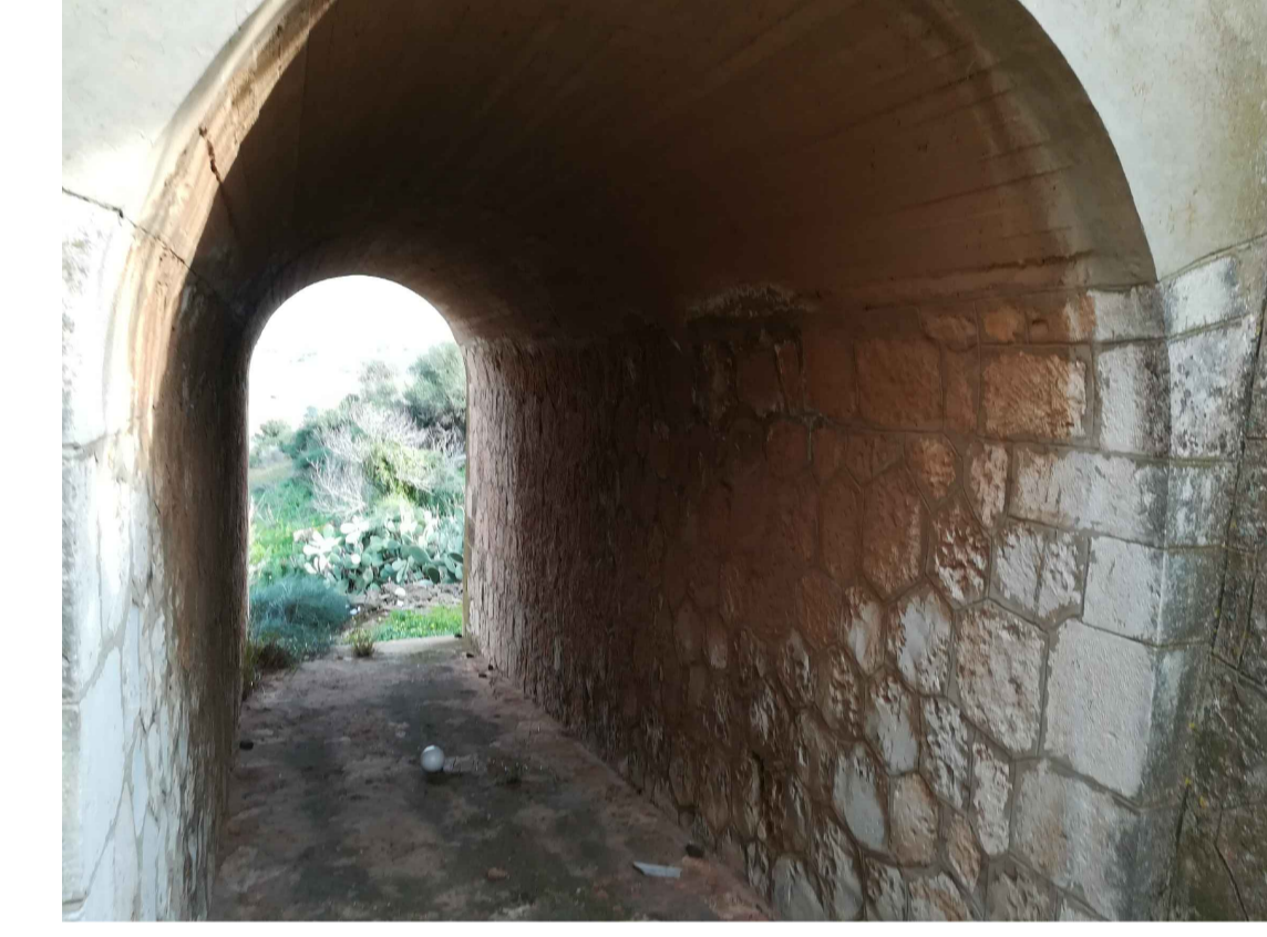
FOTO N.4 - SPALLA LATO GELA
