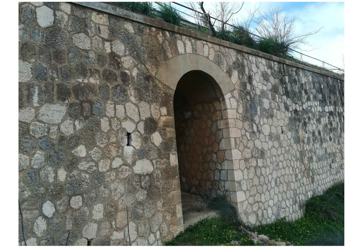
FOTO N.2 - PROSPETTO LATO VALLE
