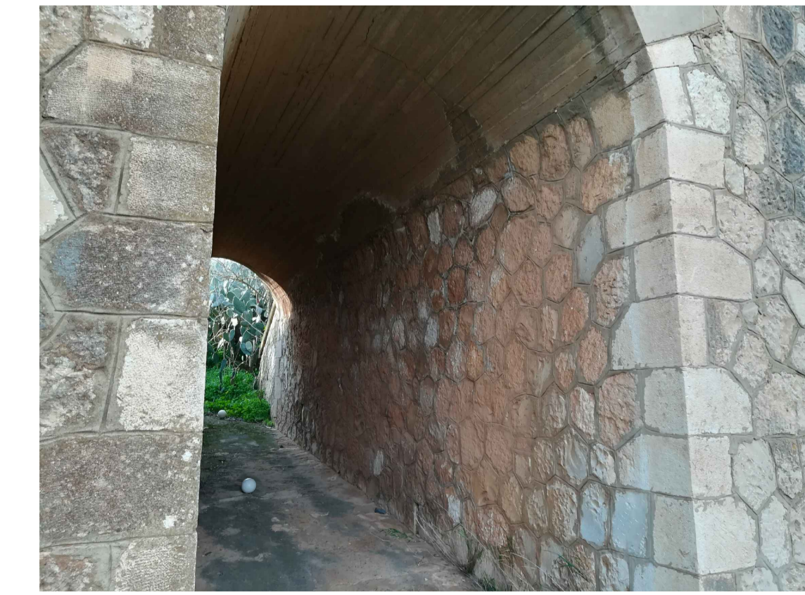
FOTO N.3 - SPALLA LATO NISCEMI
