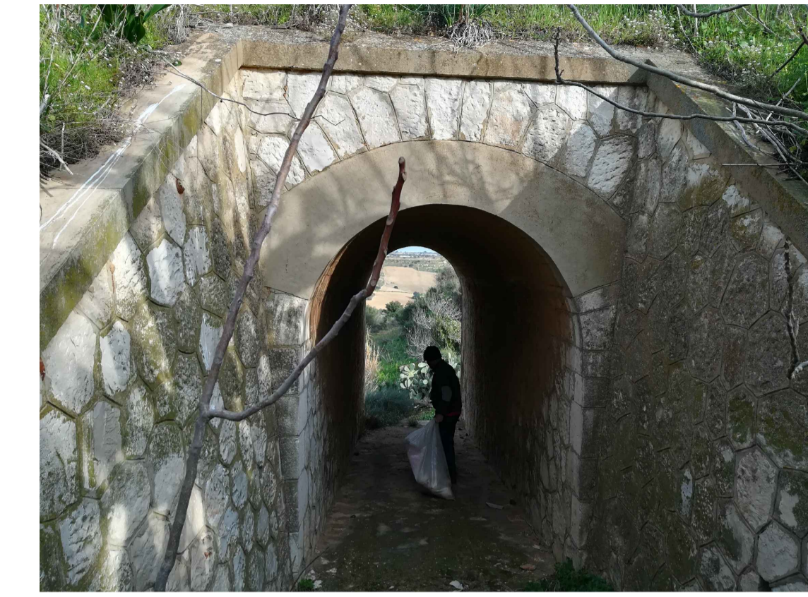
FOTO N.1 - PROSPETTO LATO MONTE
