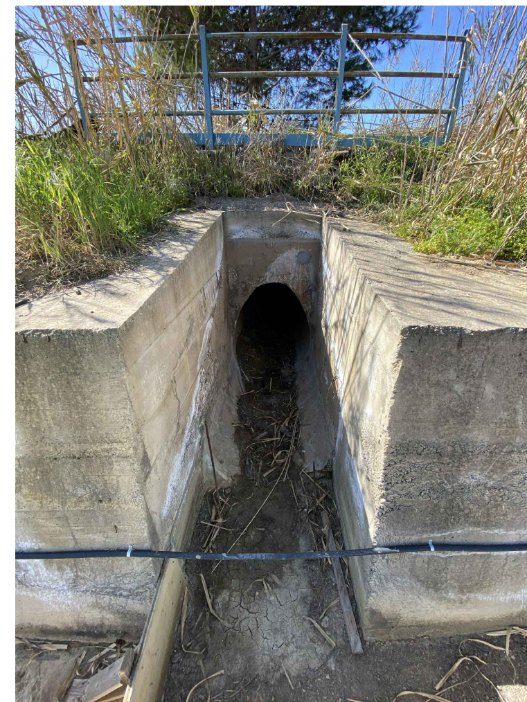
FOTO N.1 - DEGRADO - AMMALORAMENTO DOVUTO A INFILTRAZIONI SU CORDOLO - AMMALORAMENTO CLS - PROSPETTO LATO MONTE
