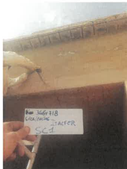
Fig. A.6 - Fase di esecuzione della prova
