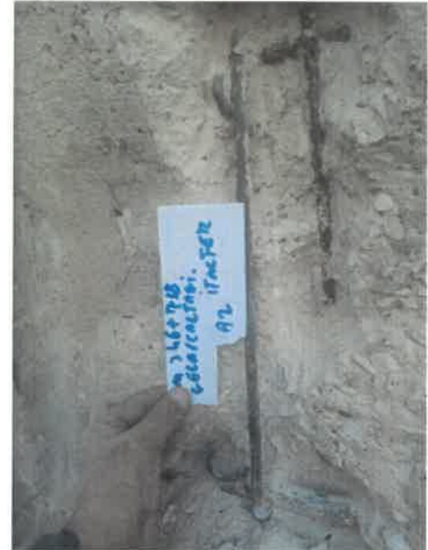
Fig. A.5 - a - Prelievo barra d'armatura
