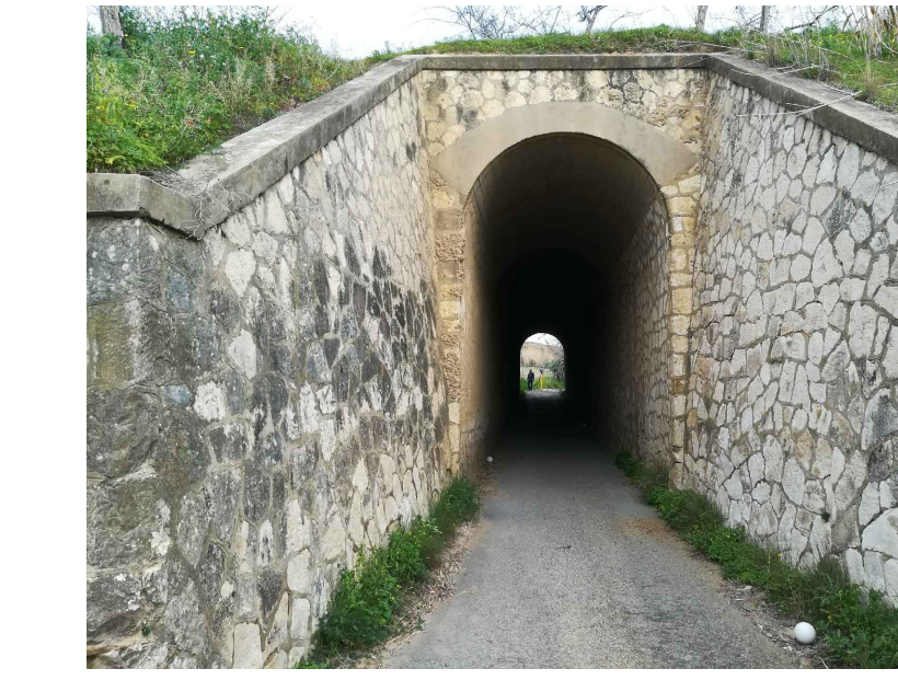
FOTO N.2 - PROSPETTO LATO VALLE
