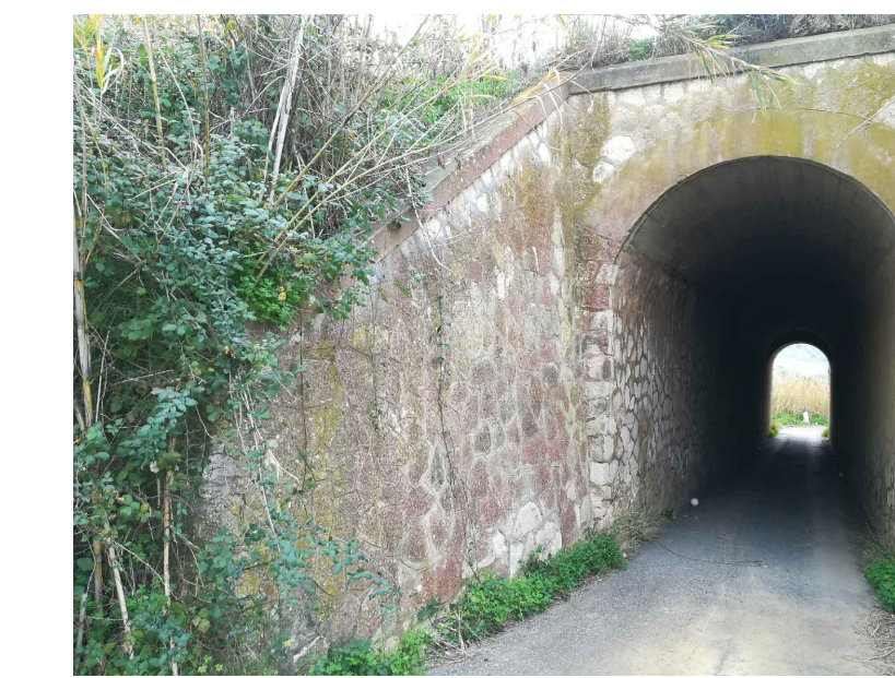
FOTO N.3 - SPALLA LATO GELA
