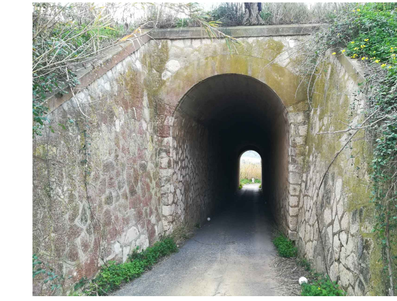
FOTO N.1 - PROSPETTO LATO MONTE
