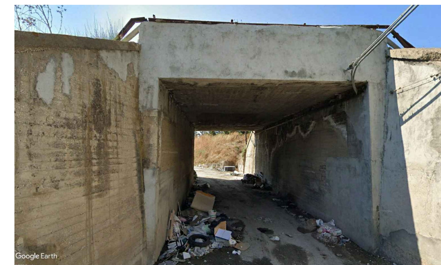
FOTO N.1 - PROSPETTO LATO MONTE
