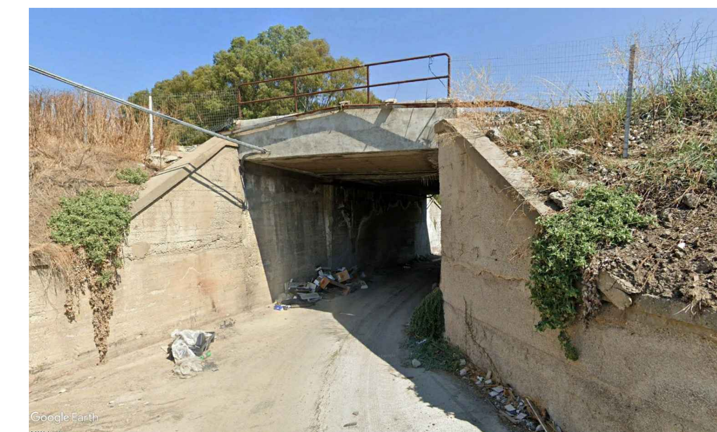
FOTO N.2 - PROSPETTO LATO VALLE
