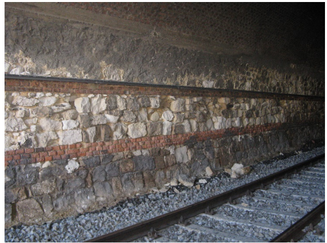
Figura 2 – Piedritti con muratura in blocchi di pietrame e ricorsi in mattoni pieni
