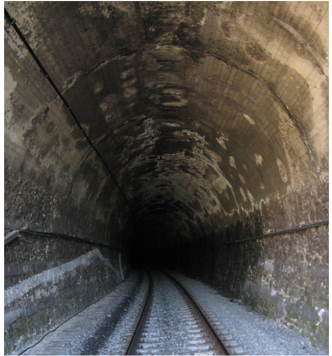
Figura 4 - Calotta in calcestruzzo
