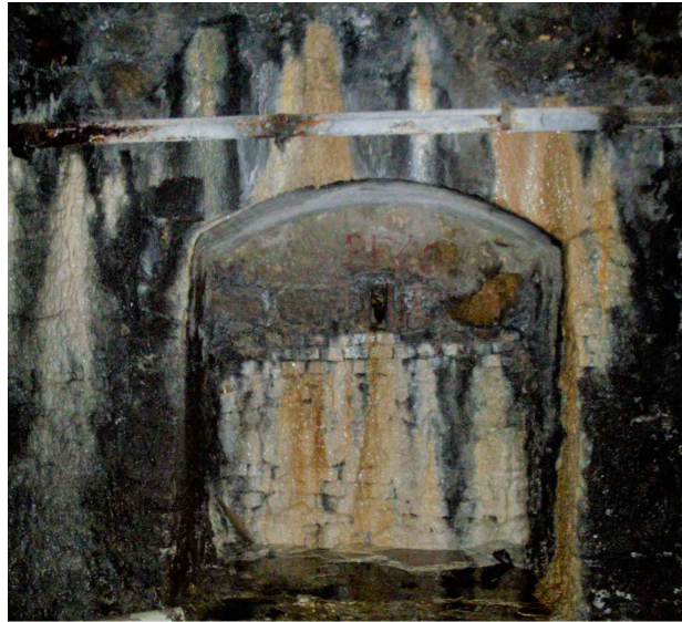
Figura 21 – Nicchia con concrezioni e venute d’acqua
