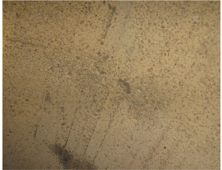
Figura 20 – Segregazione degli inerti in calotta
