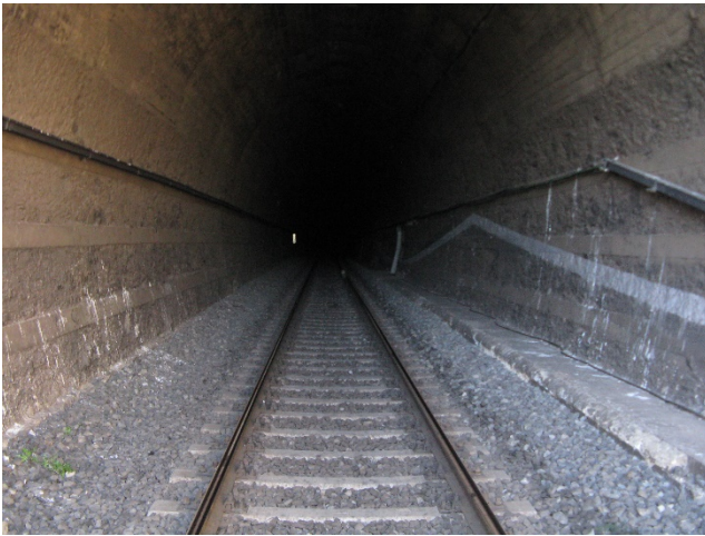
Figura 1 – Piedritti con muratura di pietrame in blocchi e ricorsi in cls
