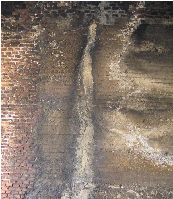
Figura 3 – Passaggio rivestimento calotta mattoni/calcestruzzo
