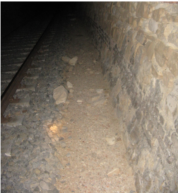
Figura 18 - Deposito di malta degradata e distacchi di pietrame proveniente dai rivestimenti – Galleria 1a di Farello
