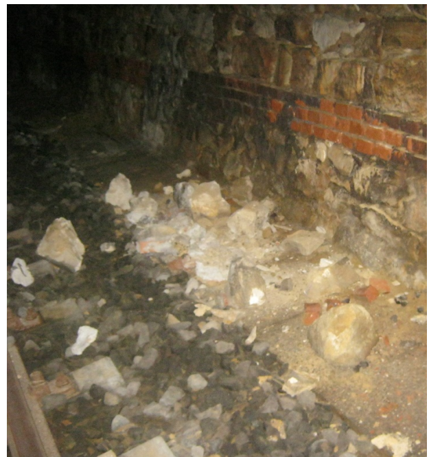
Figura 18 - Deposito di malta degradata e distacchi di pietrame proveniente dai rivestimenti – Galleria 1a di Farello
