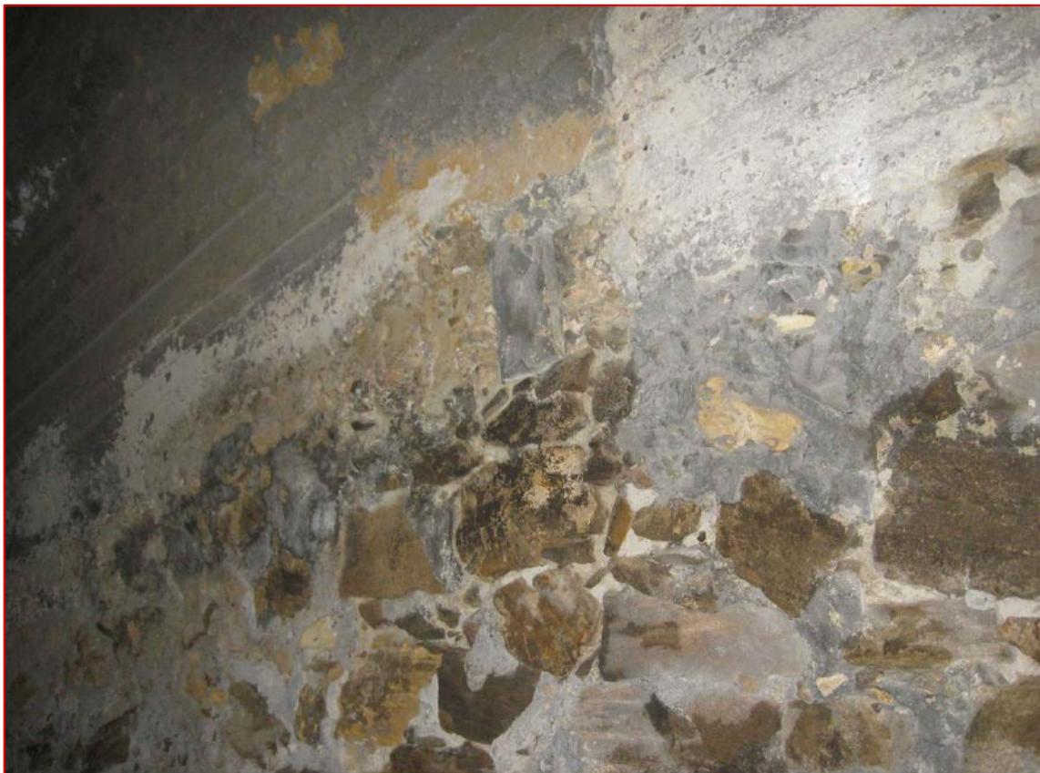
Segregazione d'inerti in calotta, polverizzazione della malta sul piedritto DX (C1, M6)
