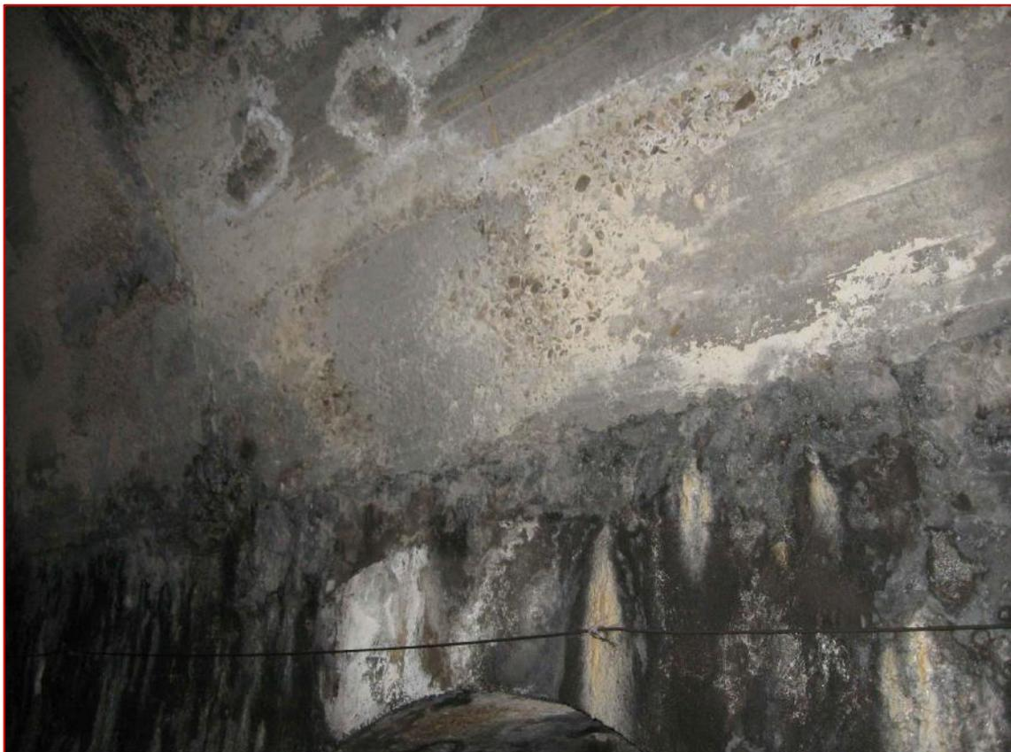
Segregazione d'inerti, venuta d'acqua e concrezioni tra calotta e piedritto DX (C1, M7)
