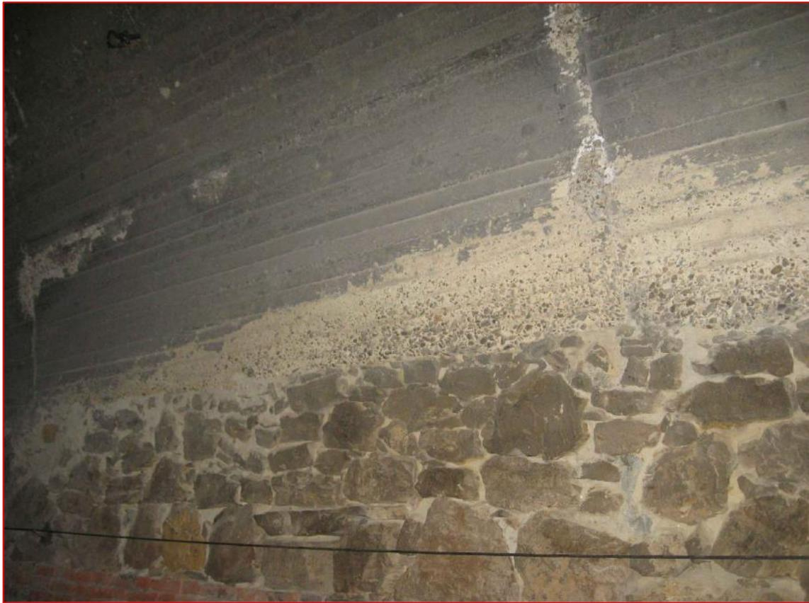
Segregazione d'inerti in calotta e polverizzazione della malta sul piedritto DX (C1, M6)
