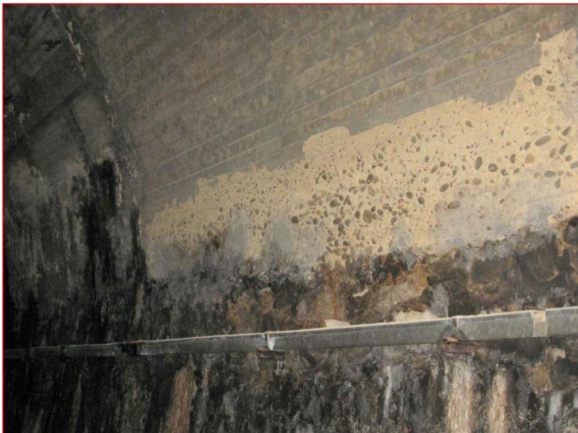
Segregazione d'inerti e concrezione tra calotta e piedritto DX (C1)
