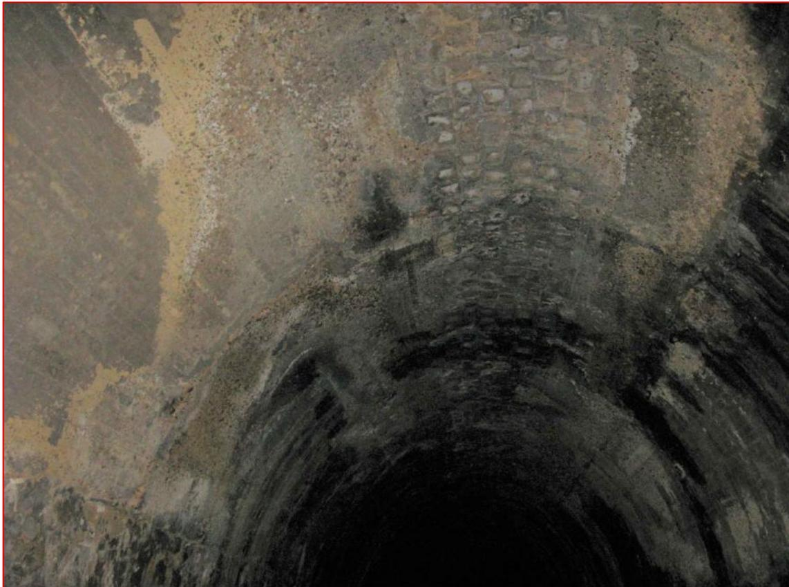
Aree umide e segregazione d'inerti in calotta (C4, C1, M1)
