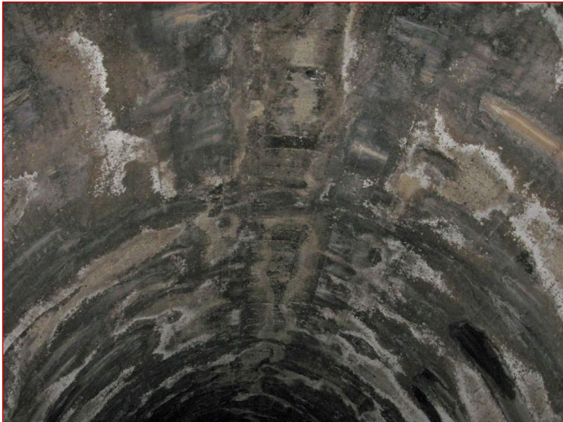
Aree umide e concrezioni in calotta (C4)
