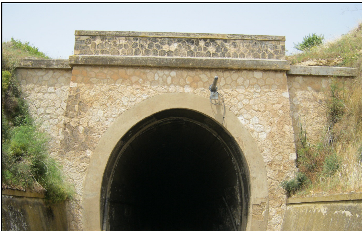
Imbocco lato Caltagirone (2011)
