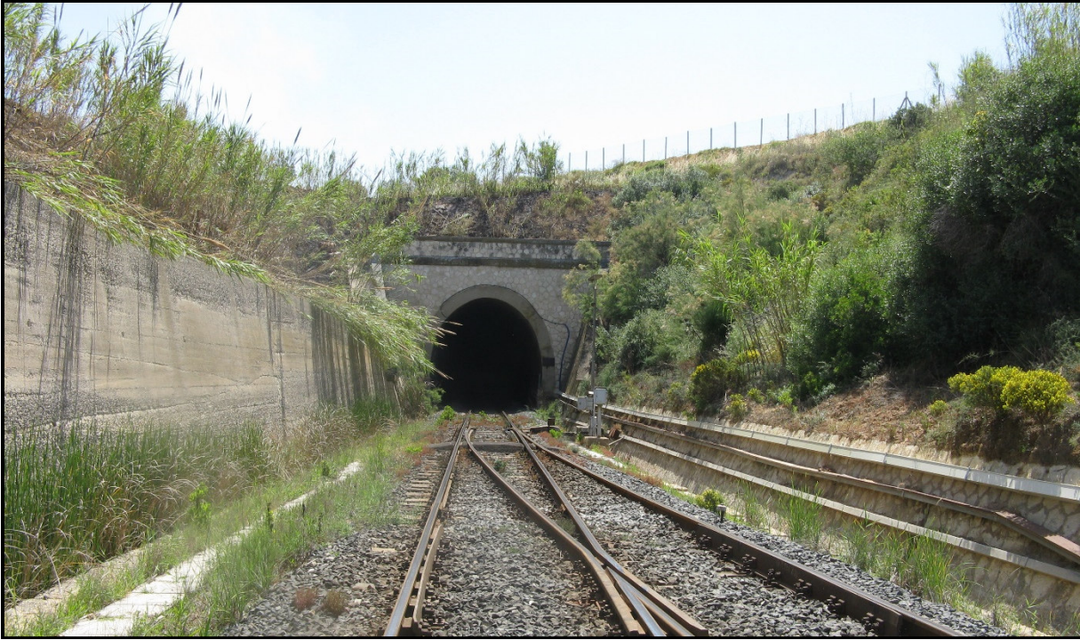
Imbocco lato Gela (2008)
