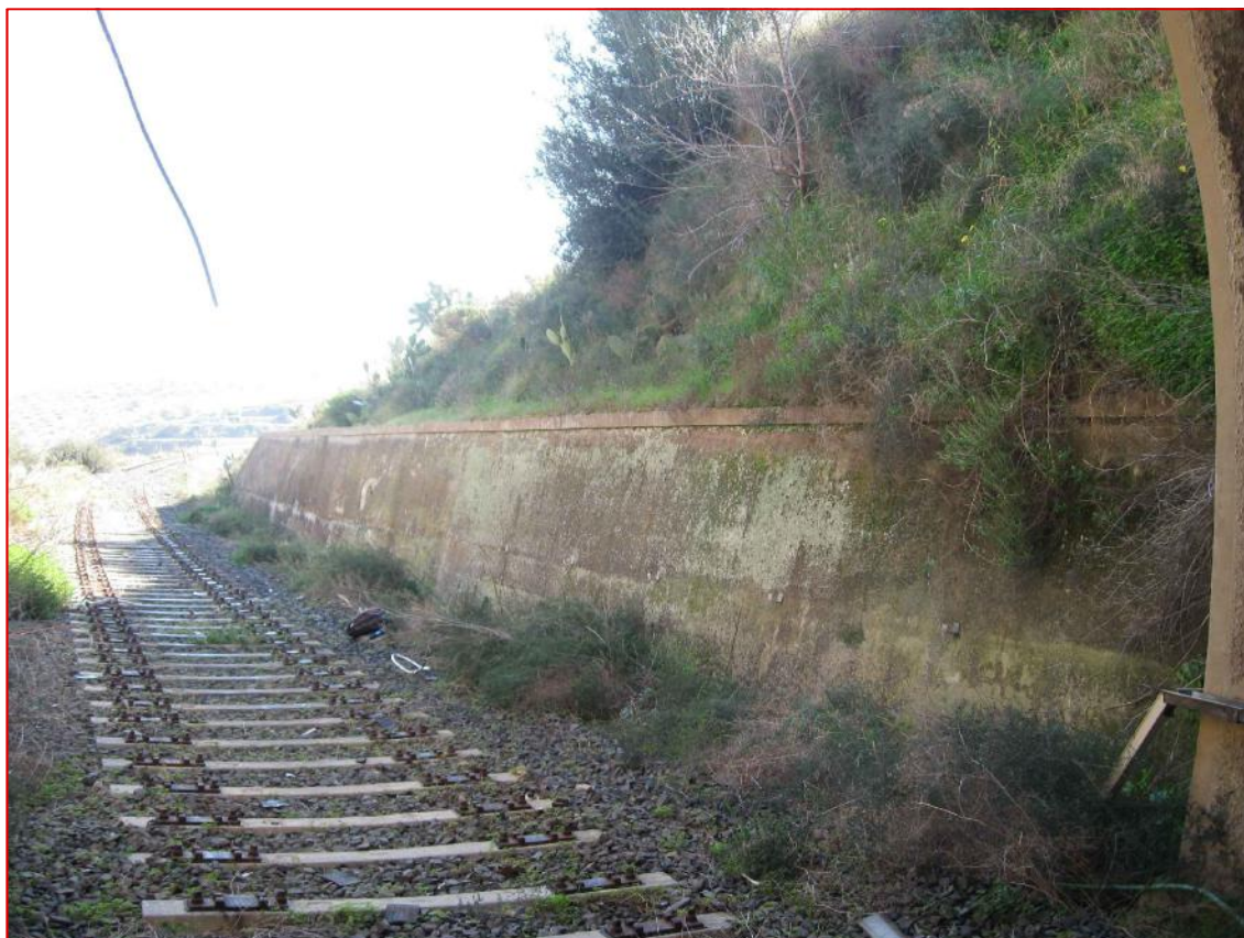
Muro d'ala SX
