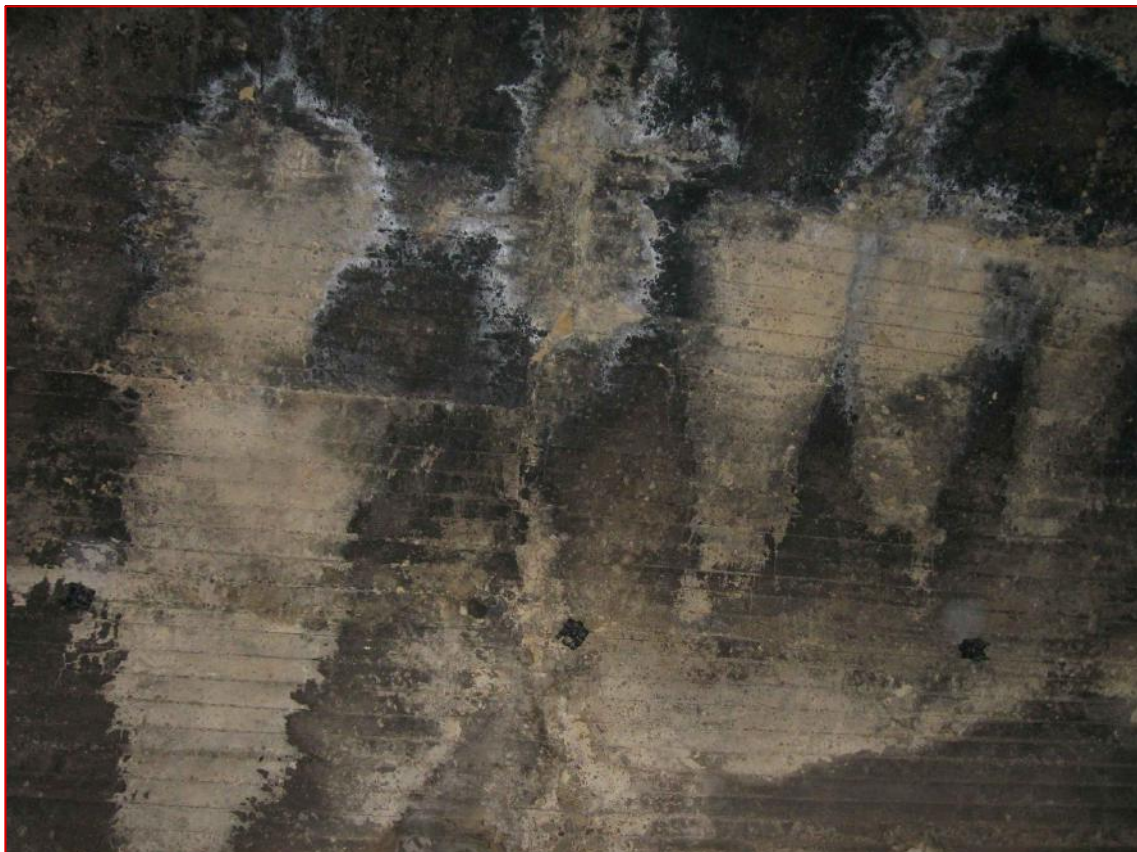
Aree umide, venute d'acqua e distacco in calotta (C4, C5, C10)
