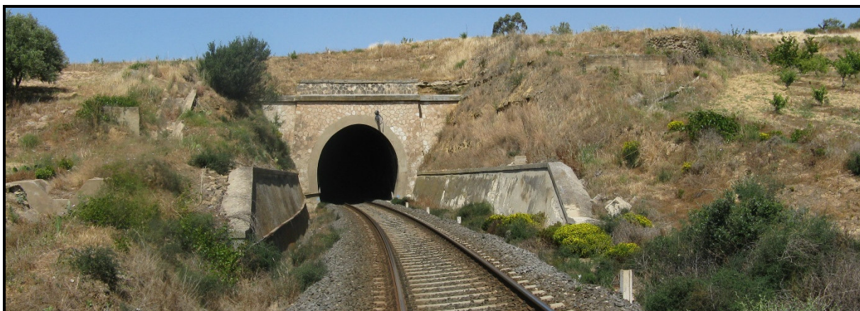
Imbocco lato Caltagirone (2008)
