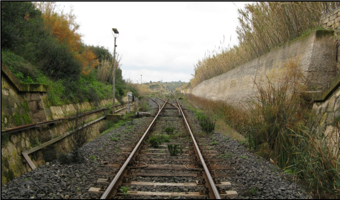
Presso imbocco lato Gela (2007)
