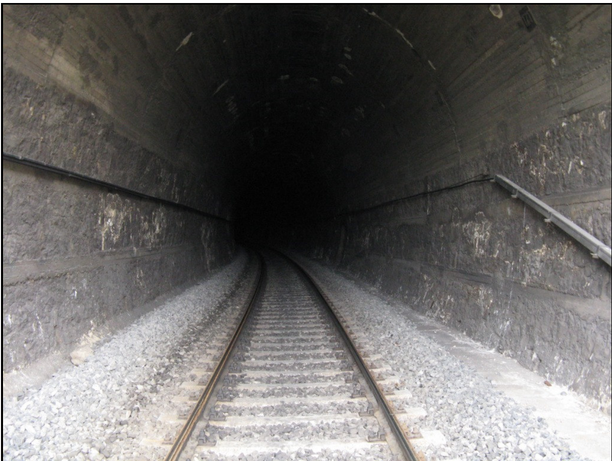
Presso imbocco lato Caltagirone (2007)
