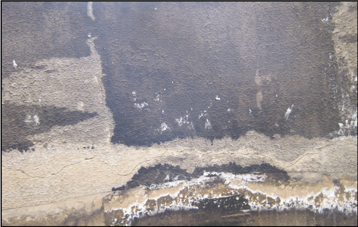
Presso imbocco lato Caltagirone (2011)
