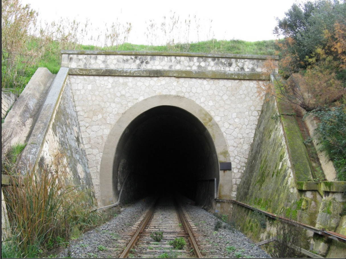
Imbocco lato Gela (2007)
