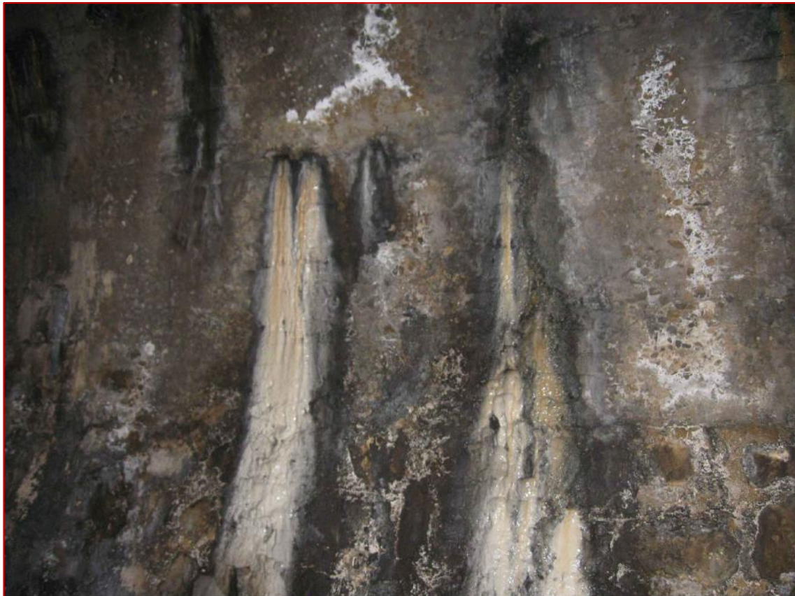
Aree umide e concrezioni tra calotta e piedritto DX (C4, M1)
