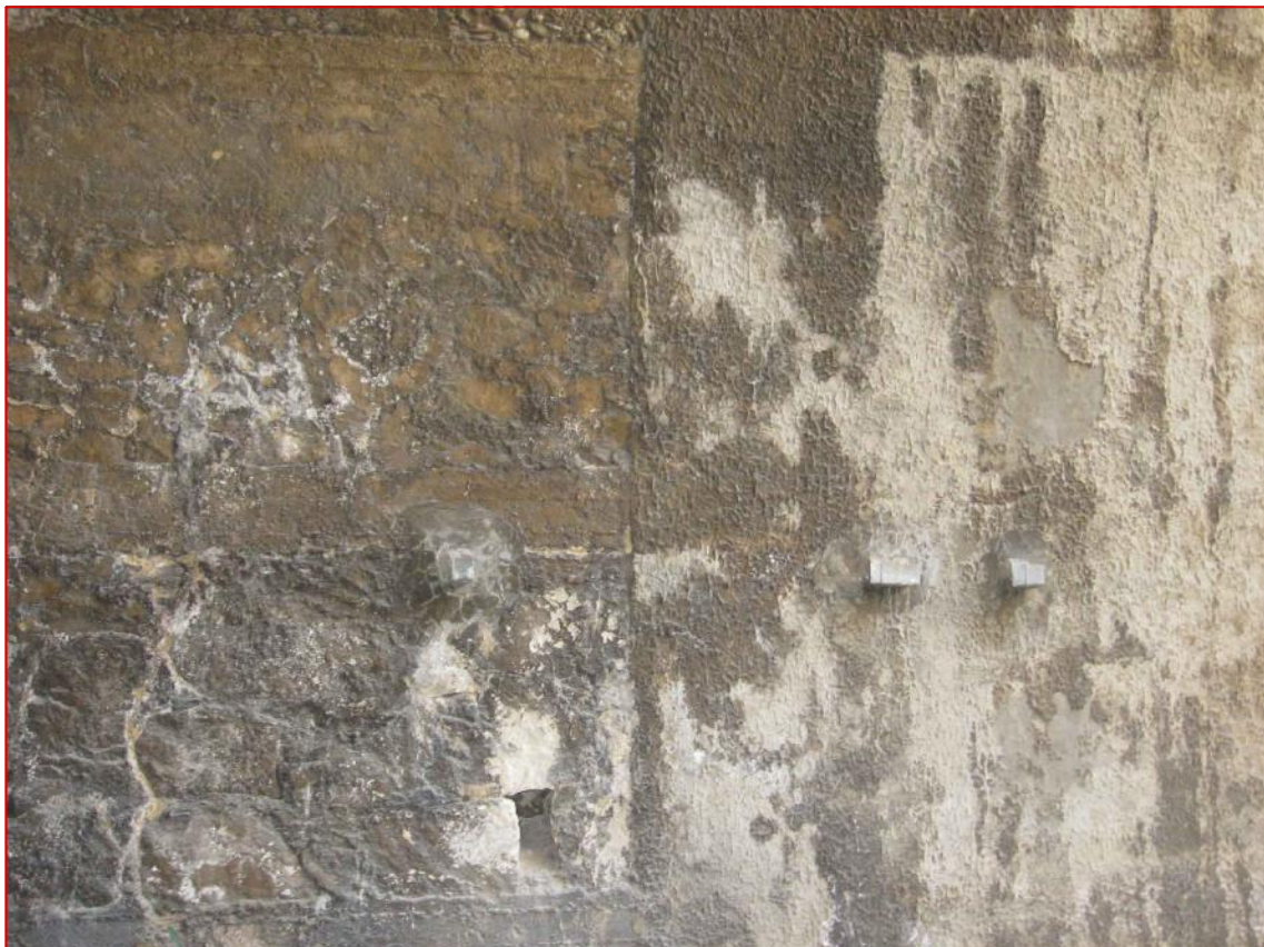
Cambio materiale nell'imbocco lato Gela, da pietra a calcestruzzo
