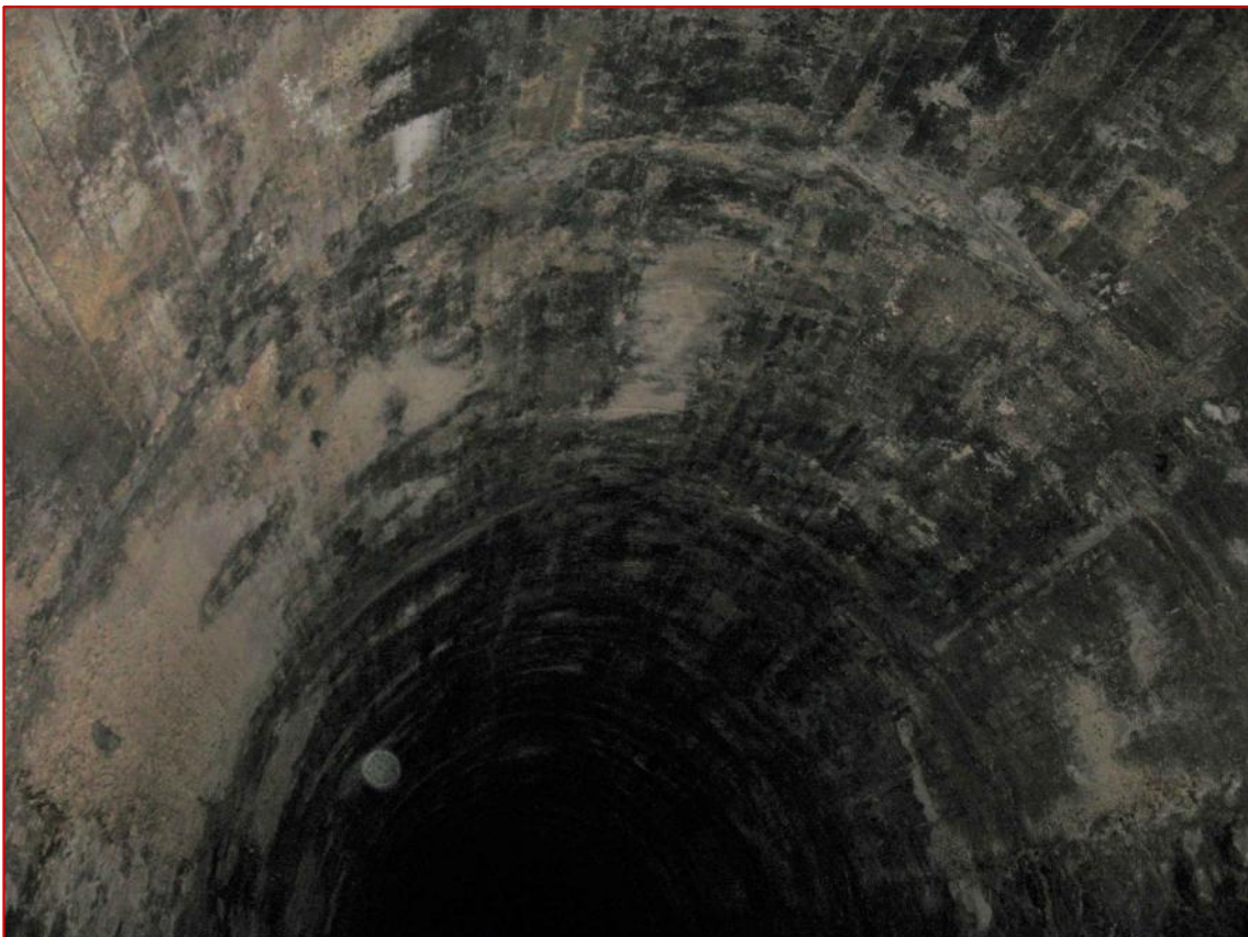
Aree umide e fessurazione in calotta (C4, C16)
