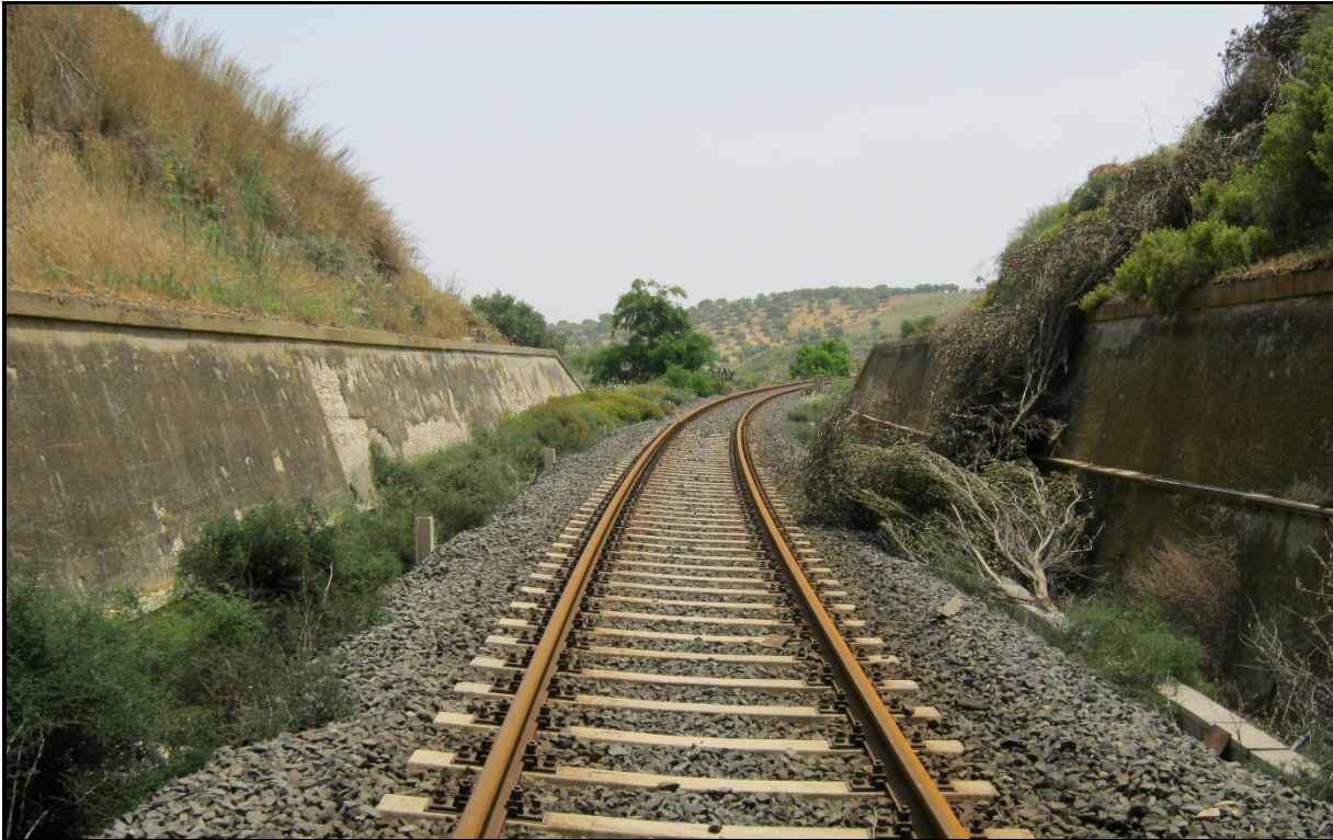
Presso imbocco lato Caltagirone (2011)
