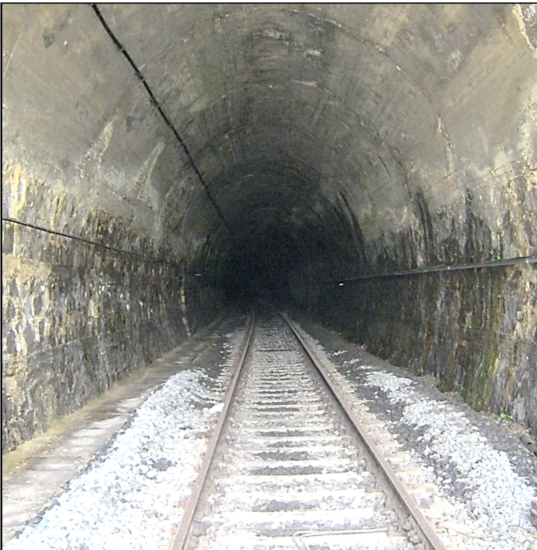
Presso imbocco lato Gela (2011)
