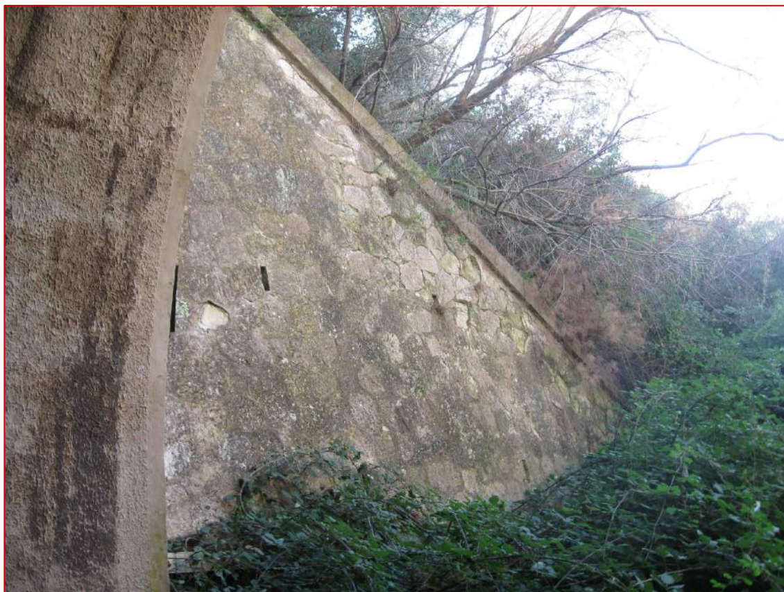
Muro d'ala SX
