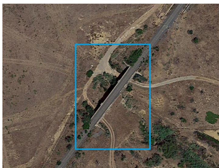
Figura 2: Vista aerea del viadotto.
