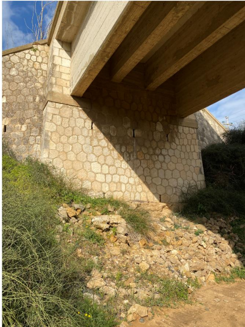
Figura 4: Spalla in muratura.
