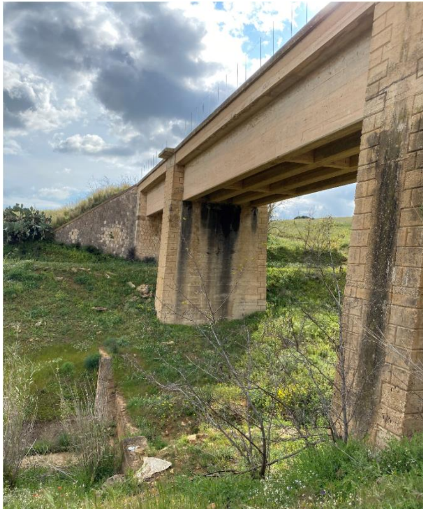
Figura 2: Implacato a graticcio in calcestruzzo armato.
