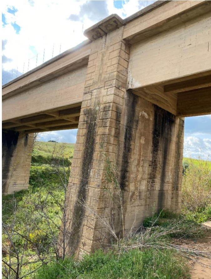
Figura 3: Pile in calcestruzzo.
