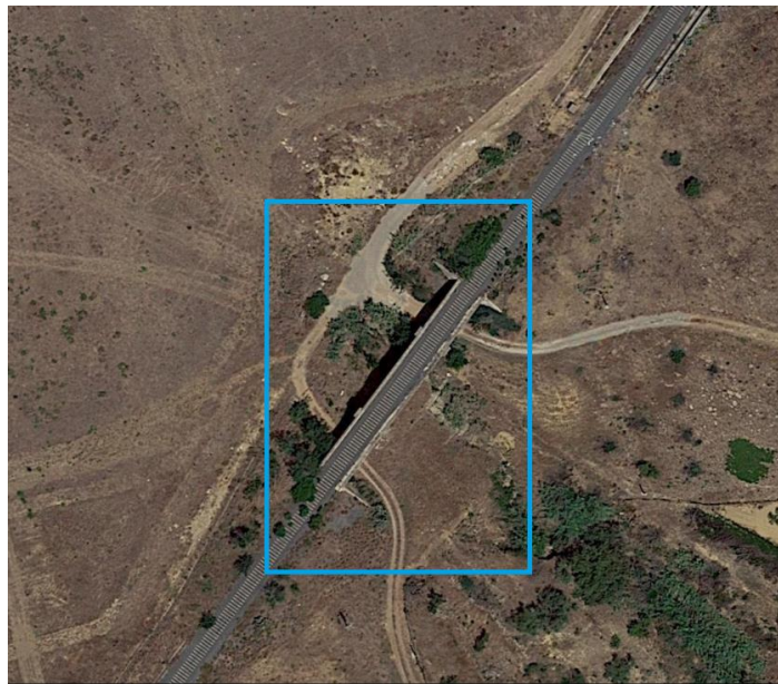
Figura 1: vista aerea dell'opera
