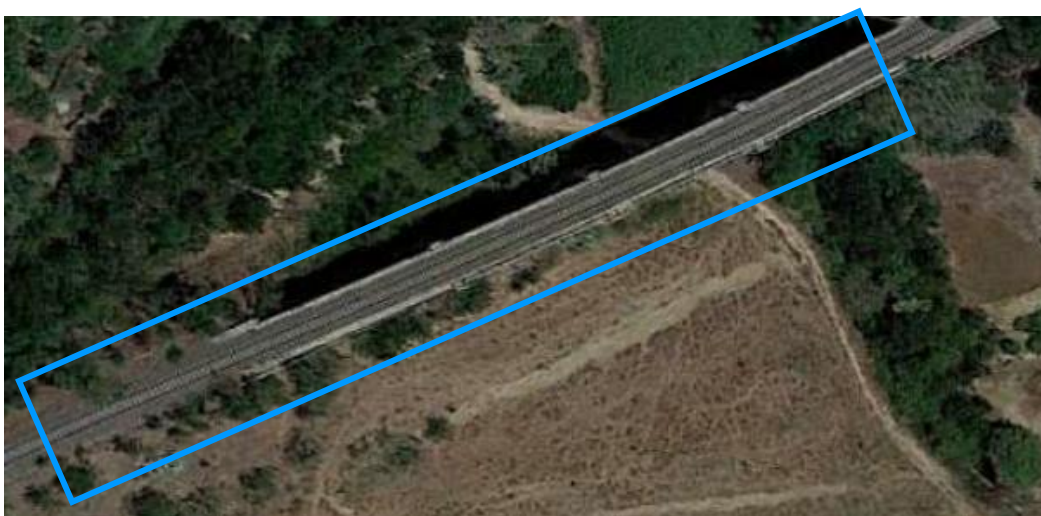
Vista aerea del Viadotto n. 2
