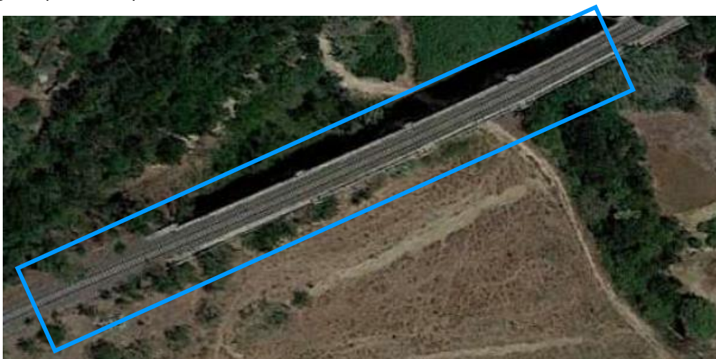
Vista aerea del Viadotto n. 2
