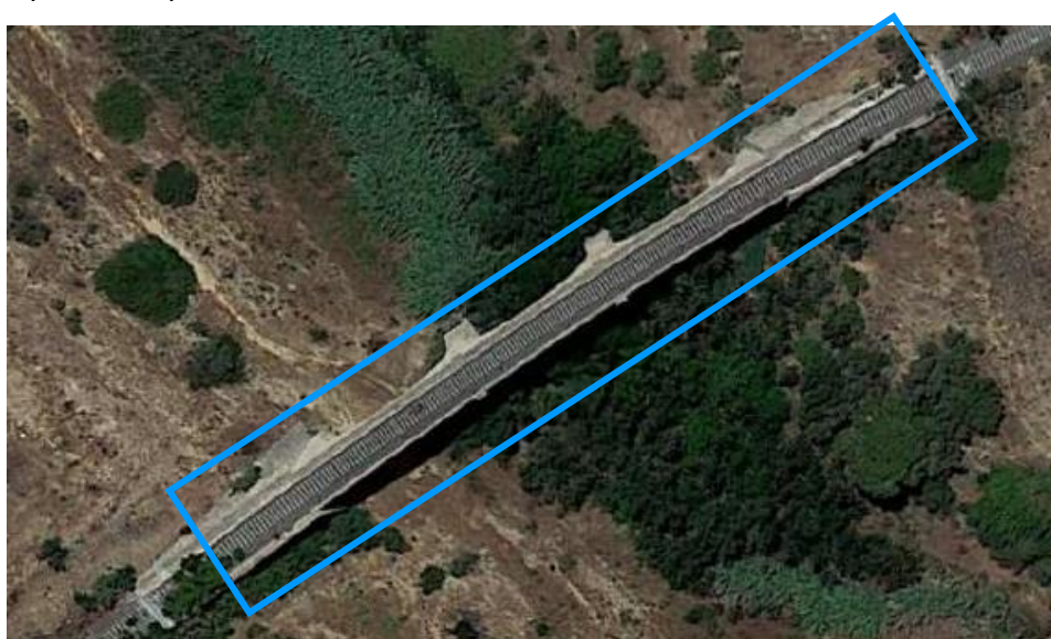
Vista aerea del Viadotto n. 4
