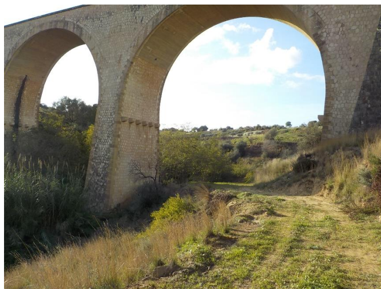
Vista del Viadotto n. 4
