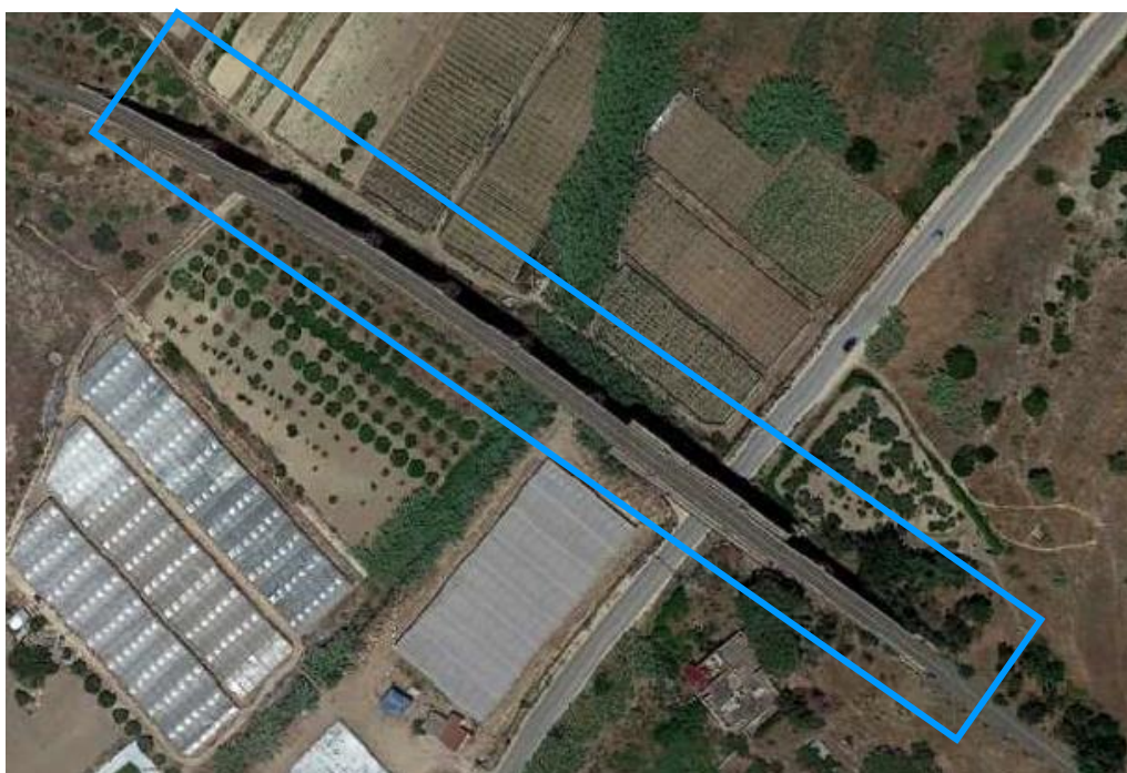
Vista aerea del Viadotto n. 5
