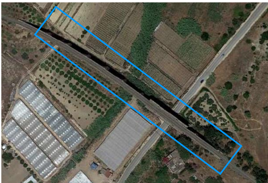
Vista aerea del Viadotto n. 5
