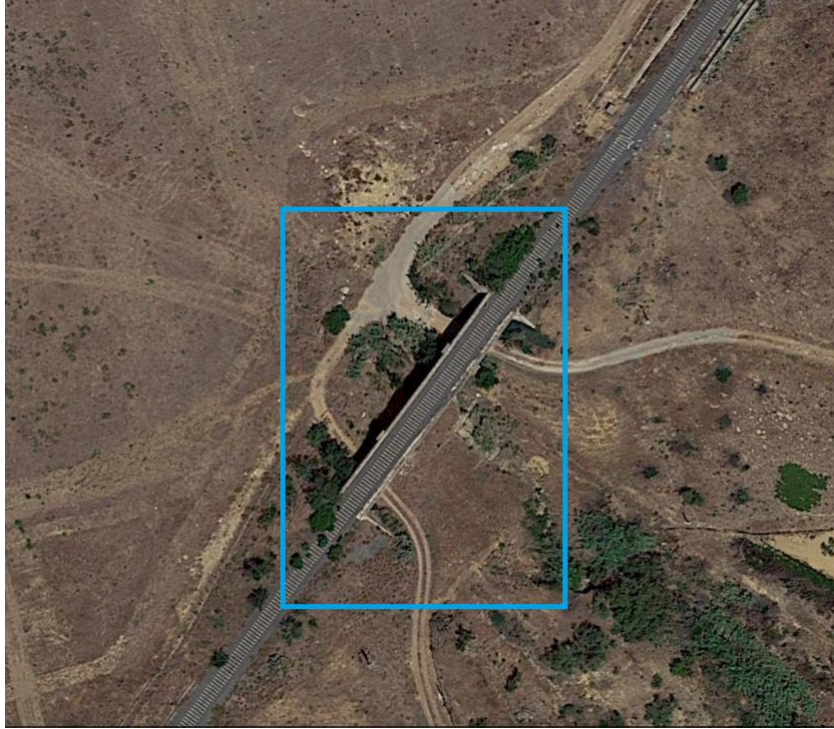
Fig. 2: Vista aerea del viadotto.
