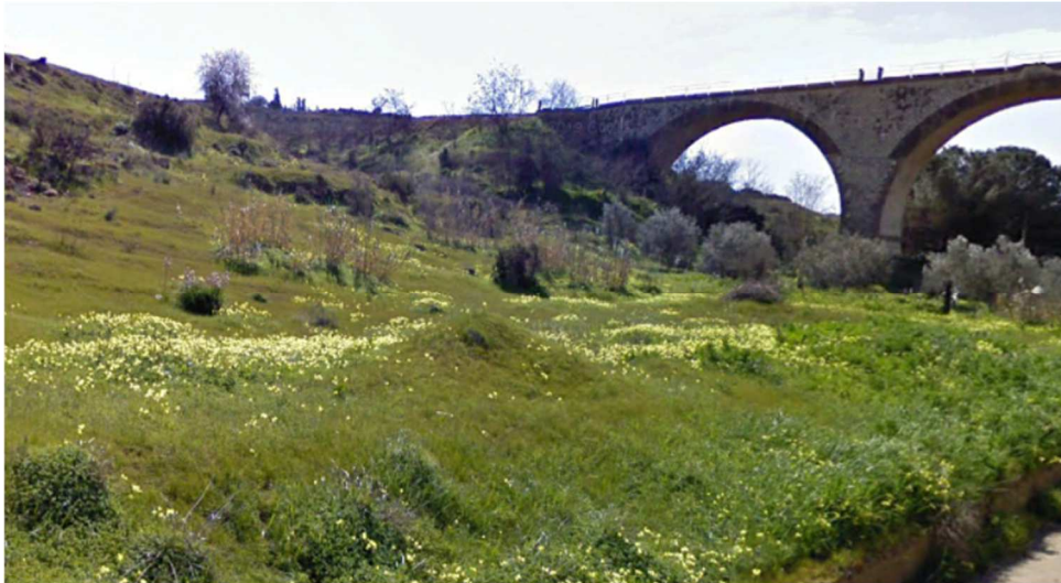
Foto 1: Area di cantiere AT.04 su Strada Provinciale SP 11
