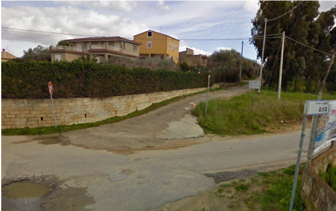
Foto 1: Vista accesso alla strada poderale da SP 11
