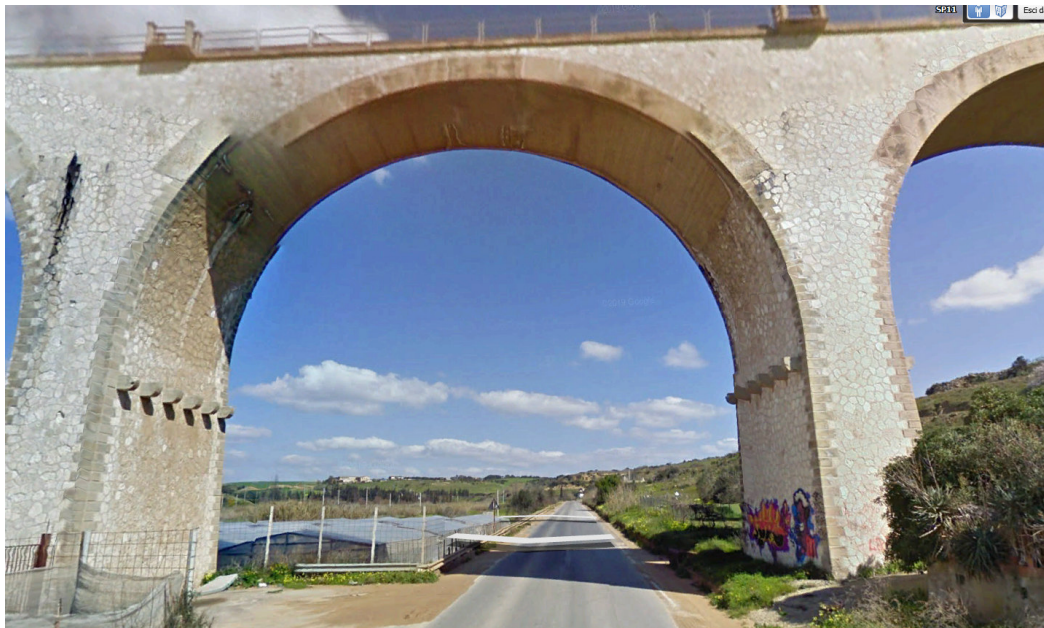
Figura 18: Vista arcata di scavalco sp n.11;
