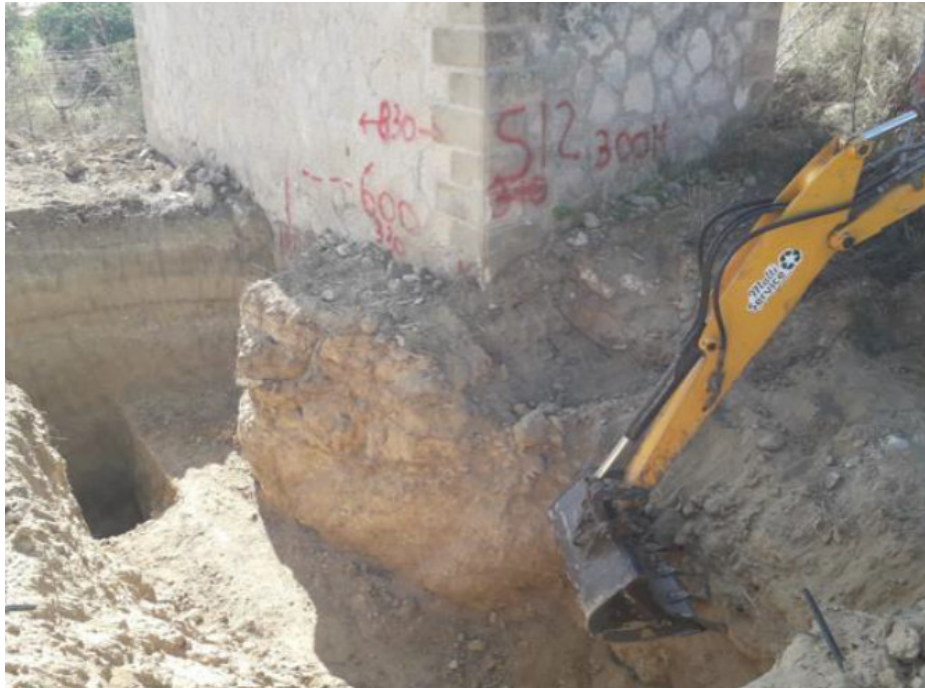
Figura 19: Saggio sul plinto di fondazione della pila 6;
