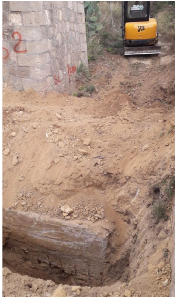
Figura 5: Dettaglio fondazione pila 4
