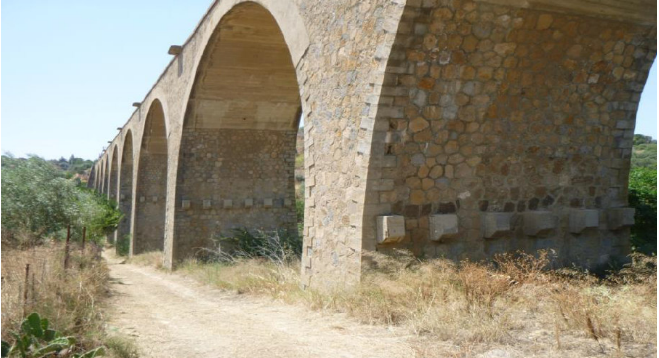
Figura 4: Immagine viadotto dal basso.
