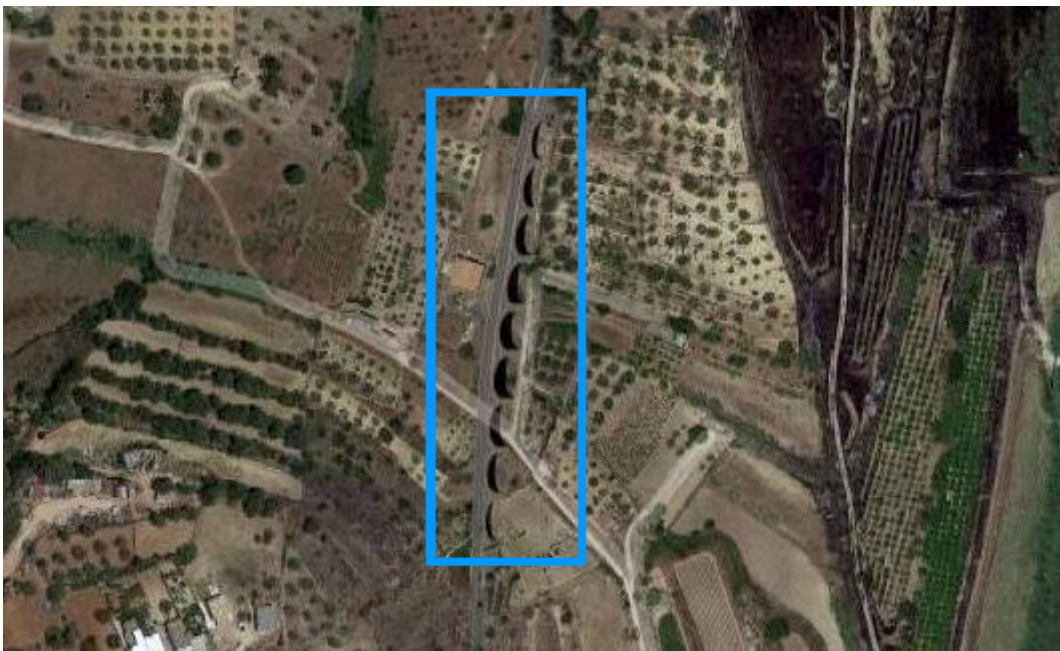
Figura 2: Vista aerea del viadotto.
