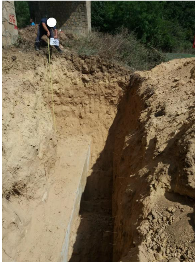
Figura 9: Scavo realizzato per geometrizzare plinto pila;
