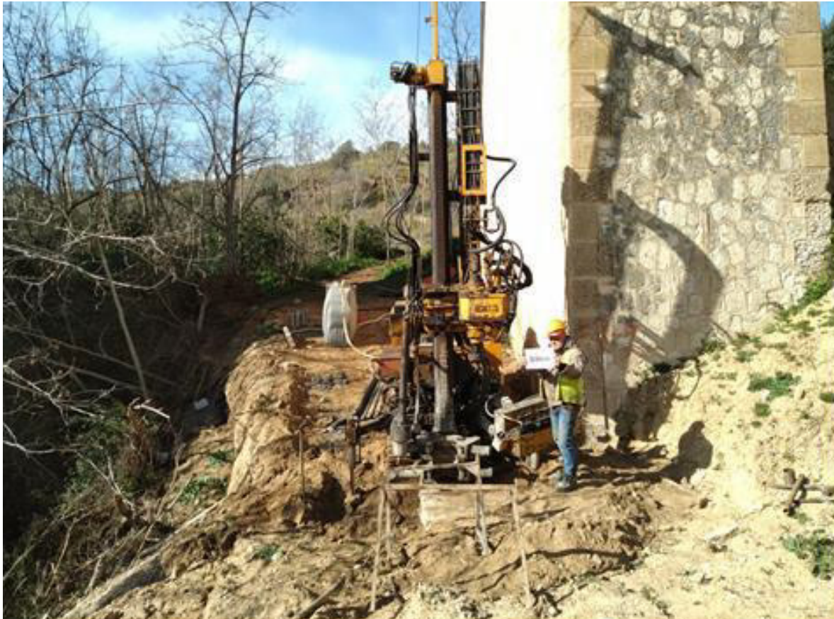
Figura 17: Vista laterale della pila 6;
