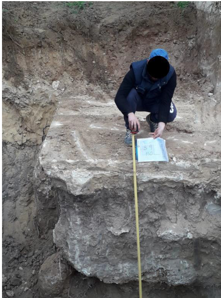
Figura 14: Saggio sul plinto di fondazione Pila 1;
