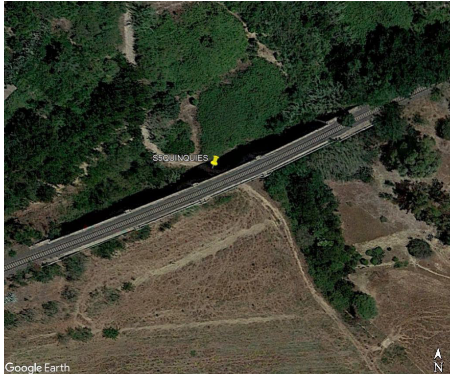
Figura 6: Vista aerea del viadotto;
