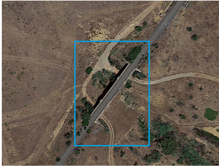
Figura 25: Vista aerea del viadotto.
