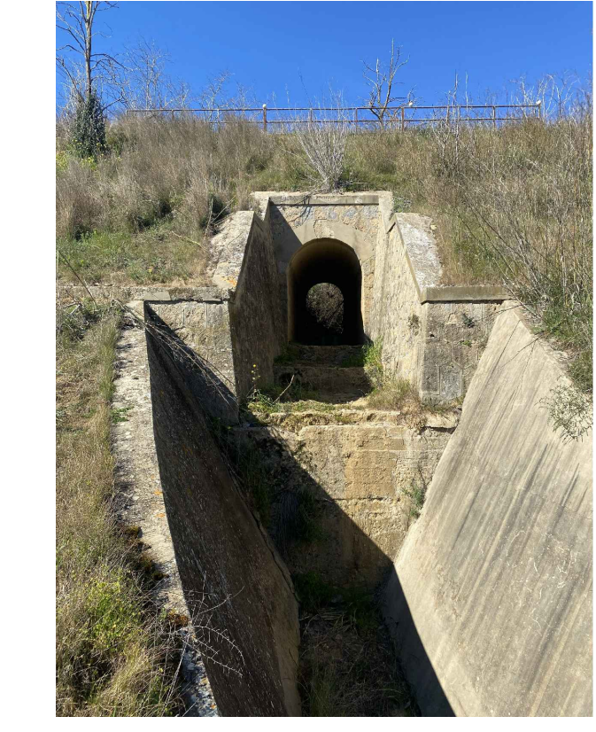
FOTO N.2 - PROSPETTO LATO VALLE
