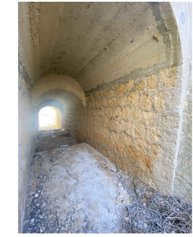
FOTO N.4 - SPALLA LATO CALTAGIRONE
