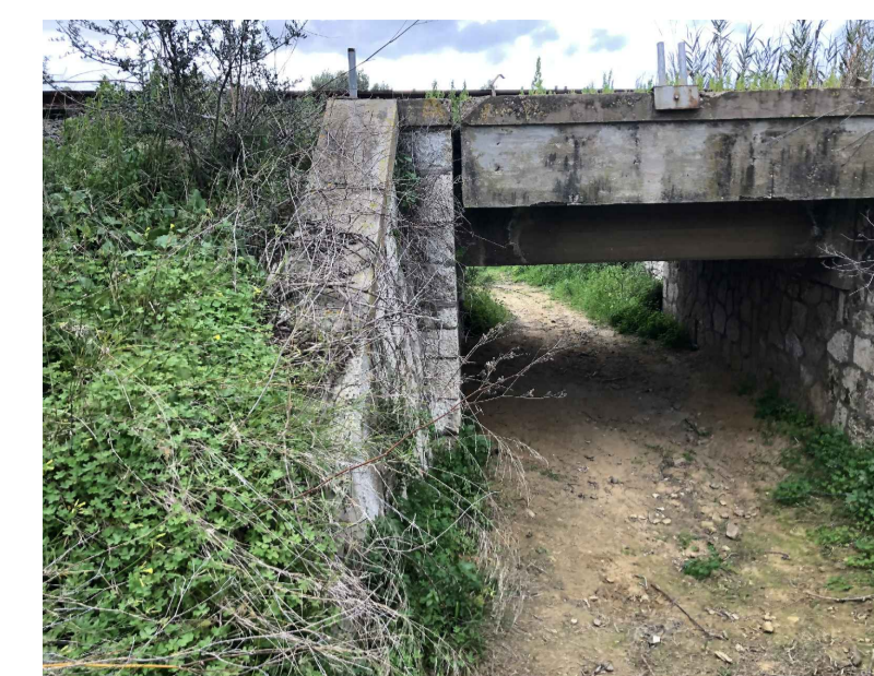
FOTO N.1 - PROSPETTO LATO MONTE
