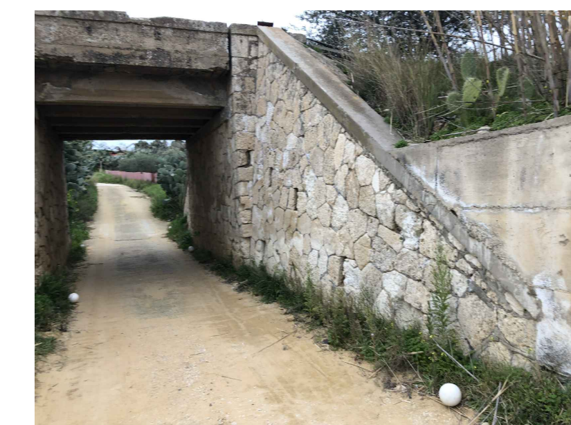
FOTO N.5 - SPALLA LATO GELA
