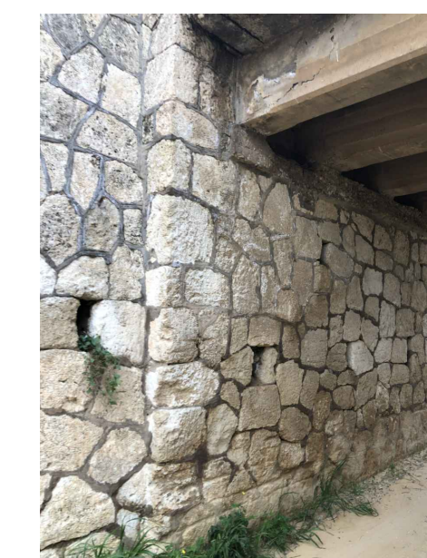
FOTO N.4 - SPALLA LATO NISCEMI
