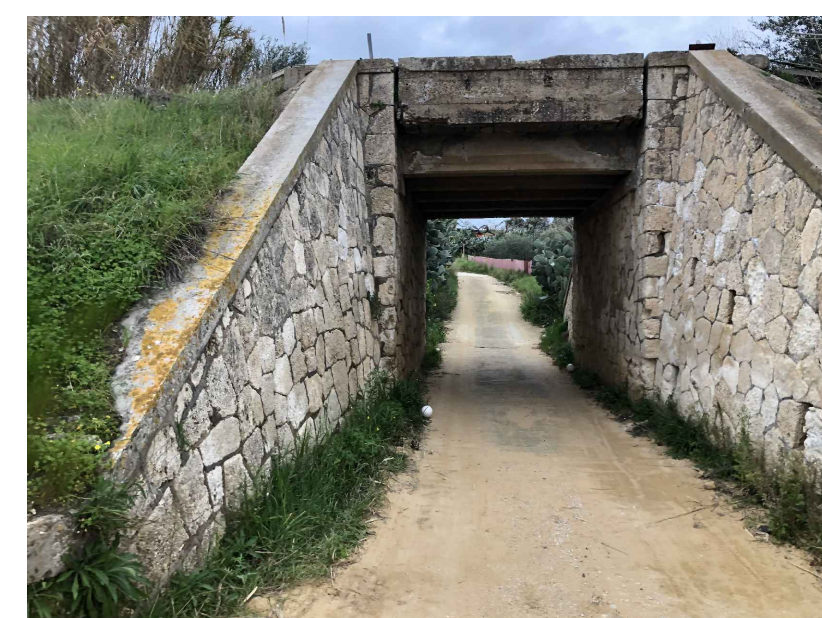
FOTO N.1 - PROSPETTO LATO MONTE
