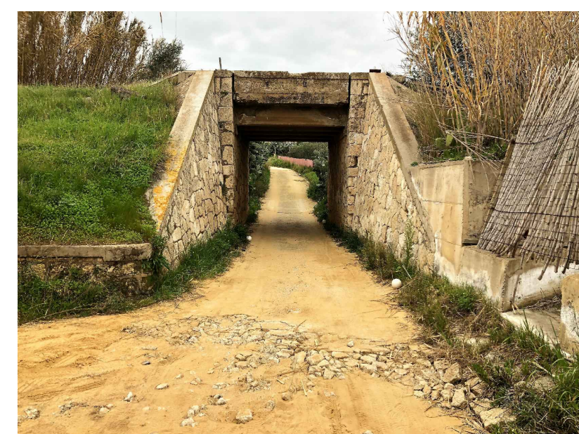
FOTO N.2 - PROSPETTO LATO VALLE
