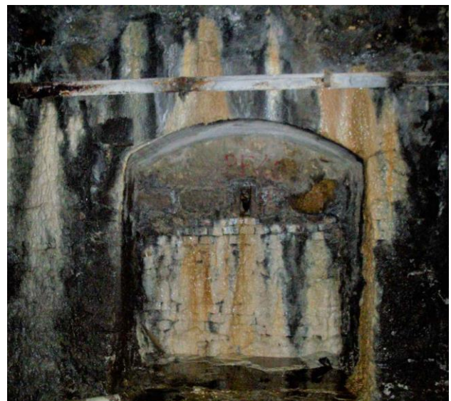
Figura 35. Nicchia con concrezioni e venute d'acqua
