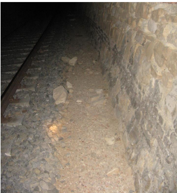
Figura 38 - Deposito di malta degradata e distacchi di pietrame proveniente dai rivestimenti – Galleria 1a di Farello
