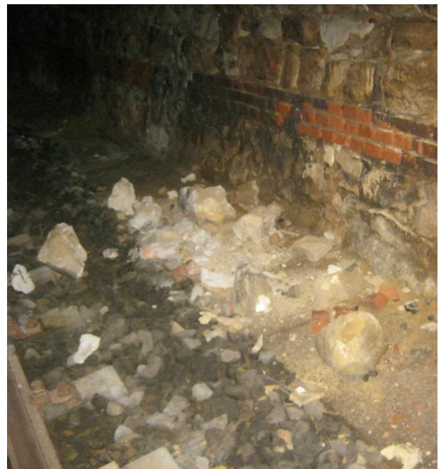
Figura 38 - Deposito di malta degradata e distacchi di pietrame proveniente dai rivestimenti – Galleria 1a di Farello
