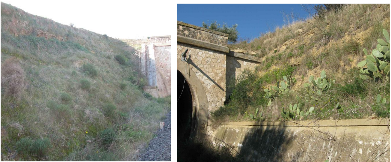
Figura 40. Situazioni tipologiche degli imbocchi: muri d'ala non sempre adatti alla morfologia esistente
