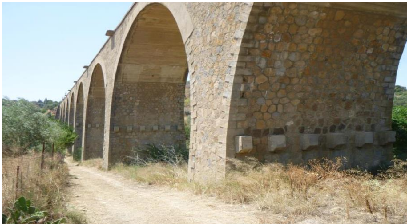
Figura 3: Immagine viadotto dal basso.
