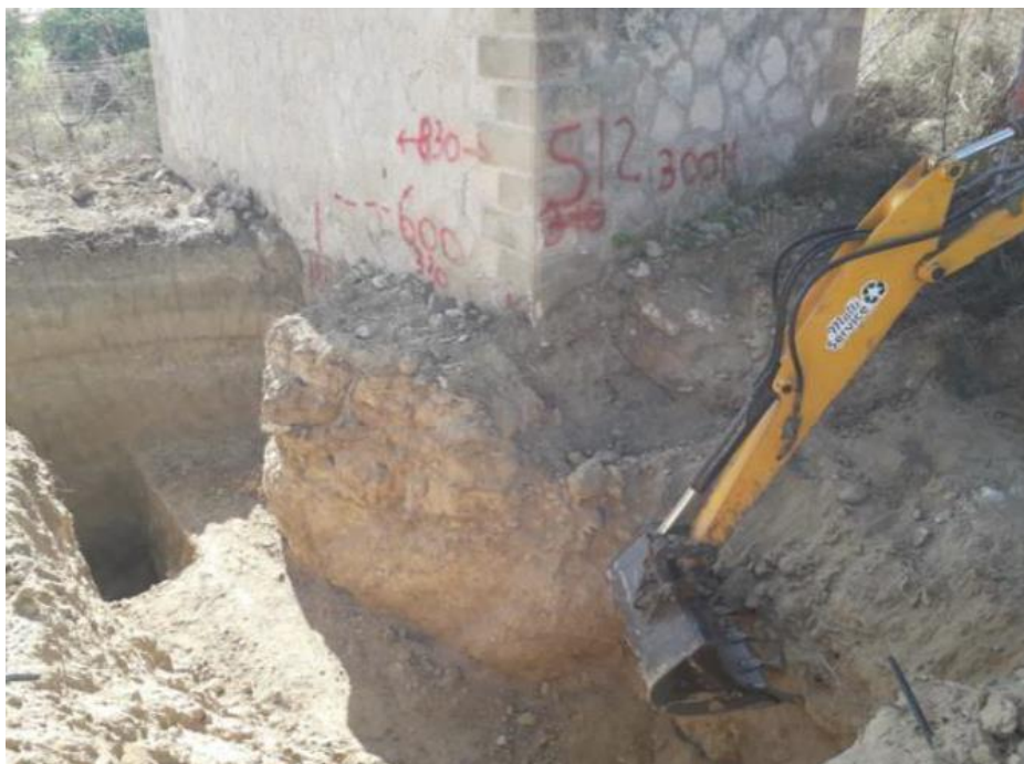
Figura 18: Saggio sul plinto di fondazione della pila 6;
