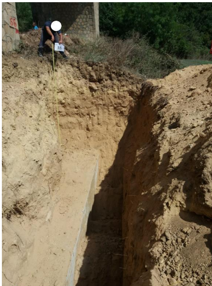
Figura 8: Scavo realizzato per geometrizzare plinto pila;
