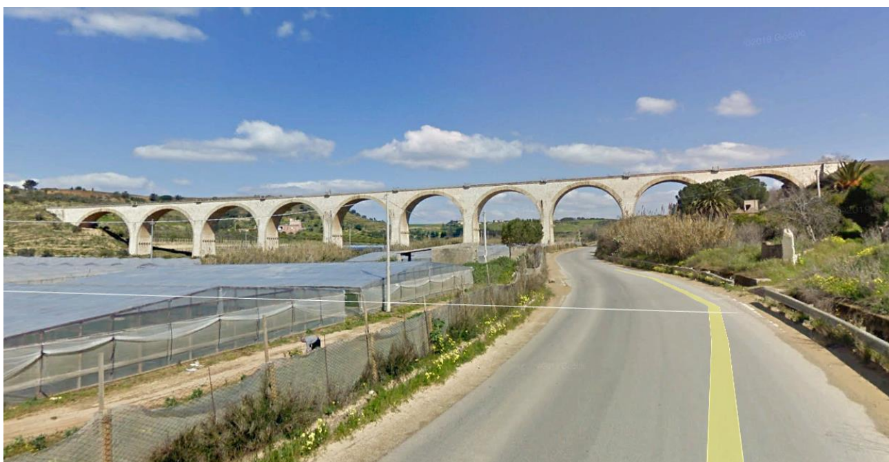
Figura 14: Vista da valle dell'opera
