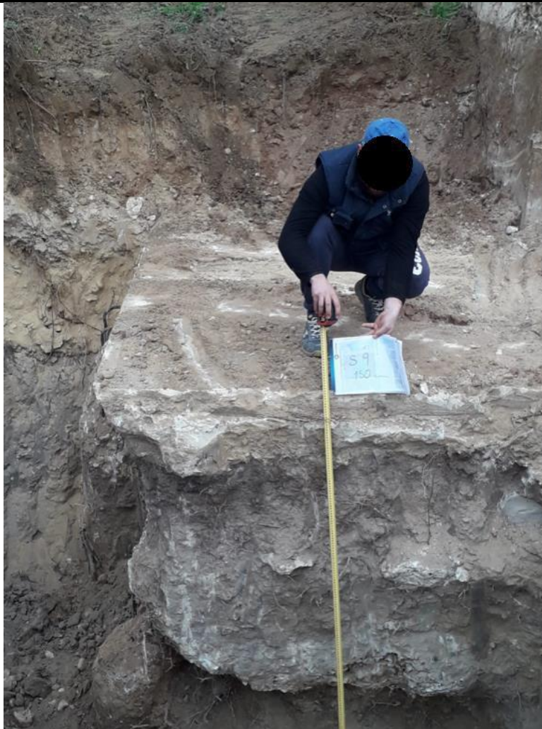
Figura 13: Saggio sul plinto di fondazione Pila 1;
