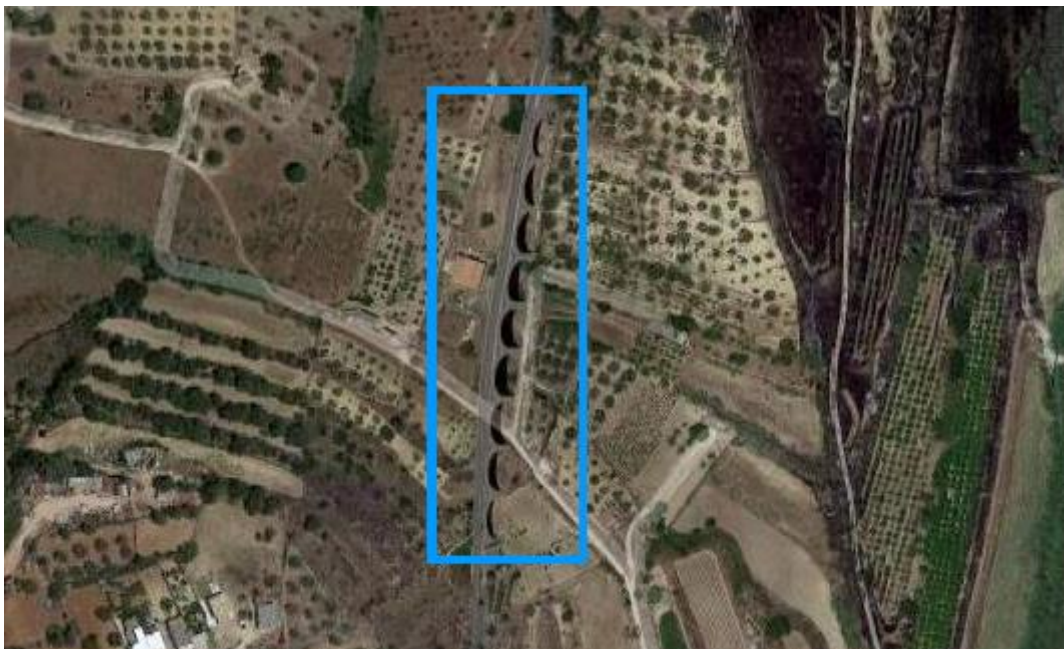
Figura 1: Vista aerea del viadotto.
