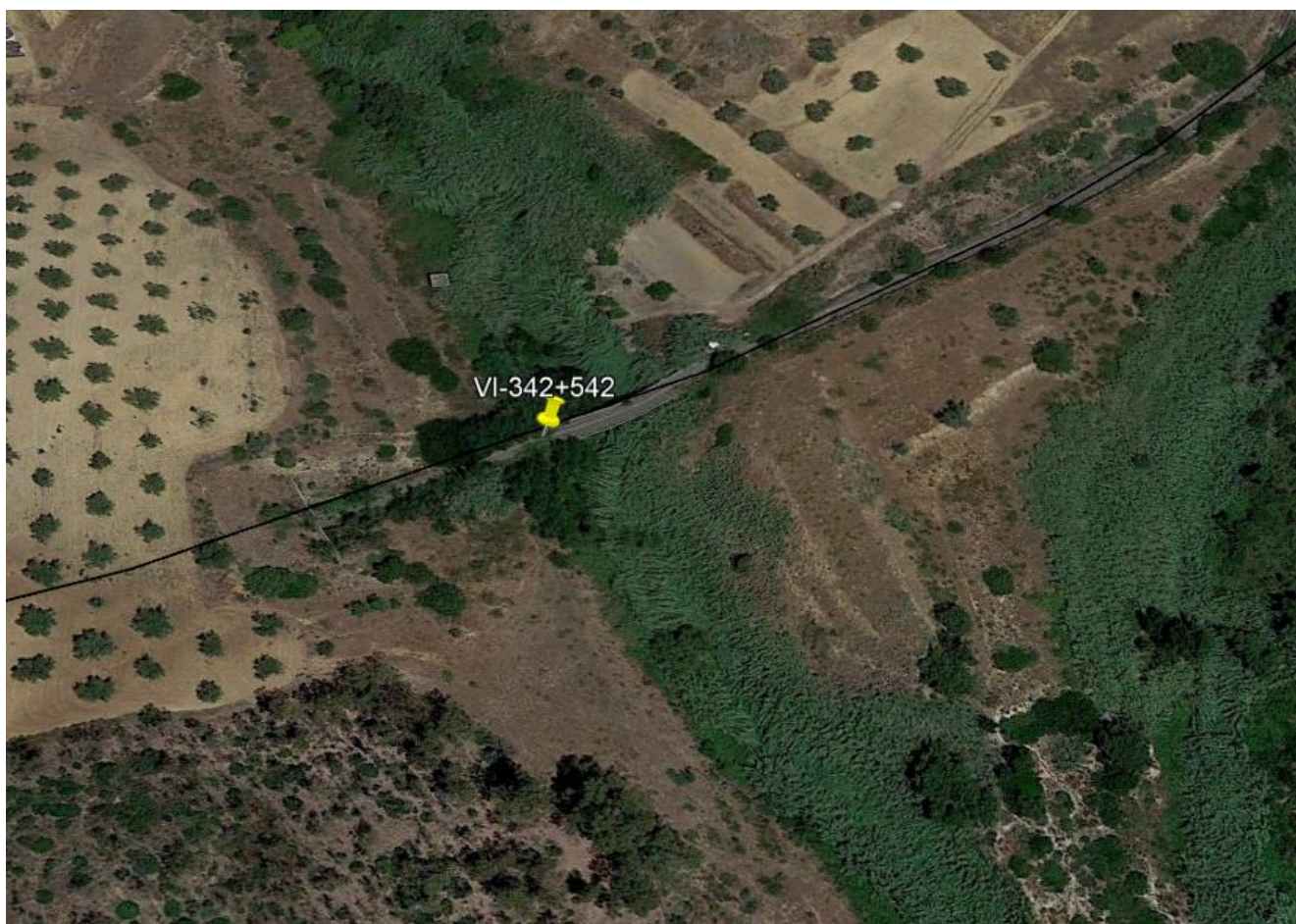
Figura 9: Vista aerea del viadotto;
