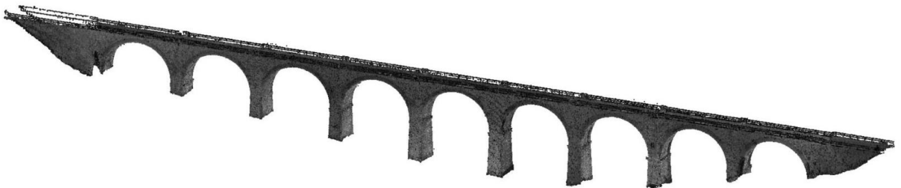
Figura 2: Restituzione laser-scanner dell'opera.
