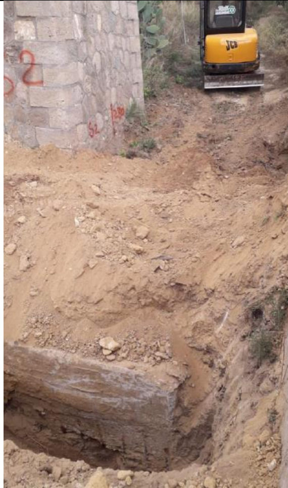
Figura 4: Dettaglio fondazione pila 4
