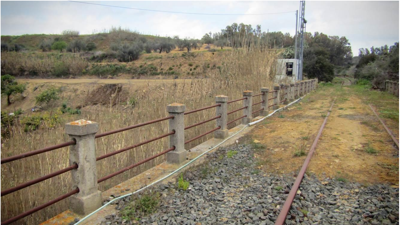
Figura 5-1- Foto ante operam dell'area destinata ad ospitare il Piazzale PT04 ed il Fabbricato tecnologico FA06.
