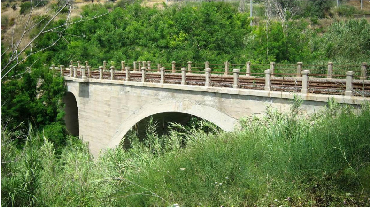
Figura 5-3- Foto ante operam del Viadotto VI03.
