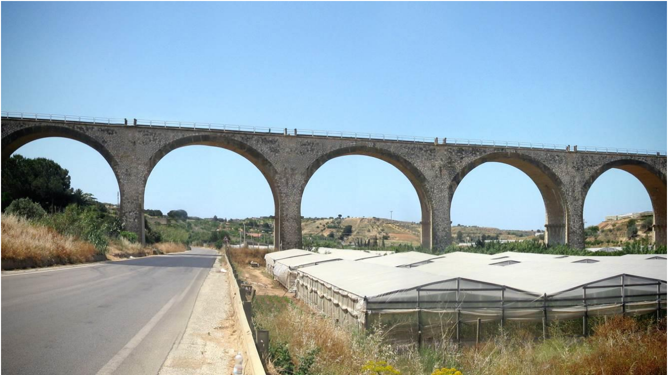
Figura 5-5- Foto ante operam del Viadotto VI05.
