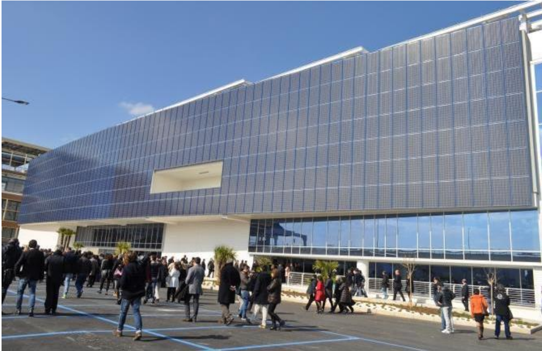
Fig. 5 : Aeroporto di Atene con impianto fotovoltaico.
