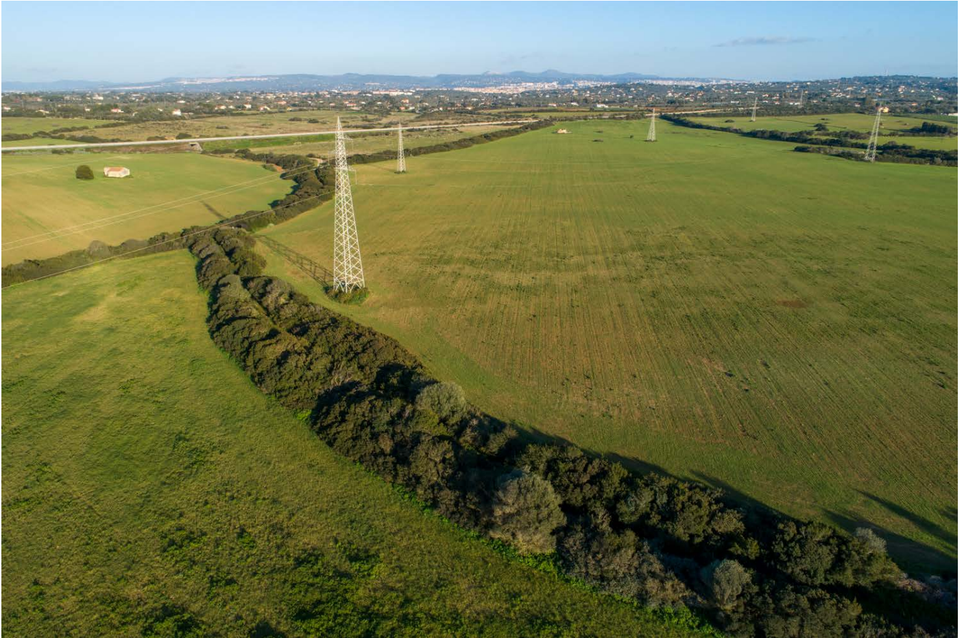
PUNTO 11 (VISTA AEREA)
