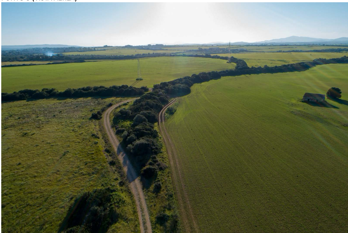
PUNTO 3 (VISTA AEREA)
