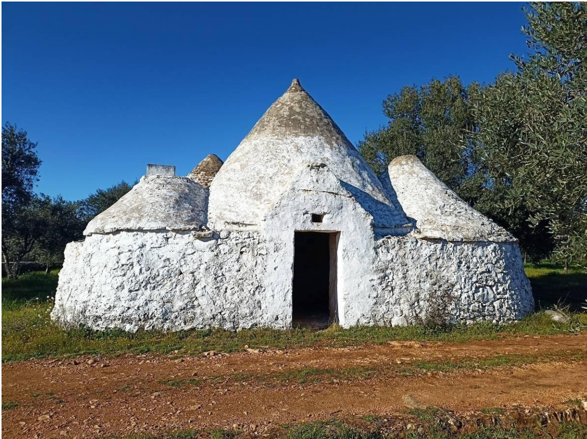
Figg. 34-34c: Alcune immagini di Masseria Cavalli scattate nel mese di Marzo 2022. La Masseria, ad oggi attiva per attività agricole, è inaccessibile al pubblico. Tuttavia l'area circostante è caratterizzata da coltivazione di ulivi e da costruzioni tipiche del territorio, i cosiddetti "Trulli".
